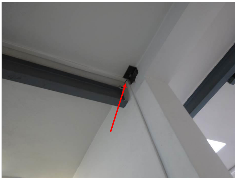
Obr.12 – Způsob uchycení kotvy v interiéru – ocelová příložka. Jedná se o jihozápadní roh.
