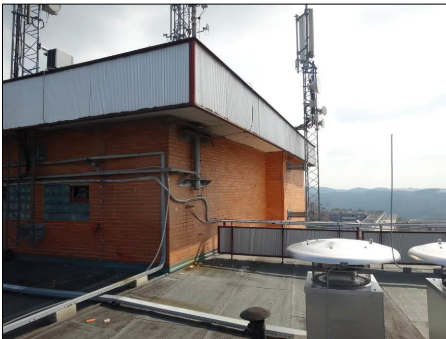
Obr.2 – pohled na jižní stěnu s ozubem. Převís střechy překlenuje obě části. Na této části je patrný prostup tyčového stožáru v přední (západní) části a předsunuté uložení příhradového stožáru v zadní části.
