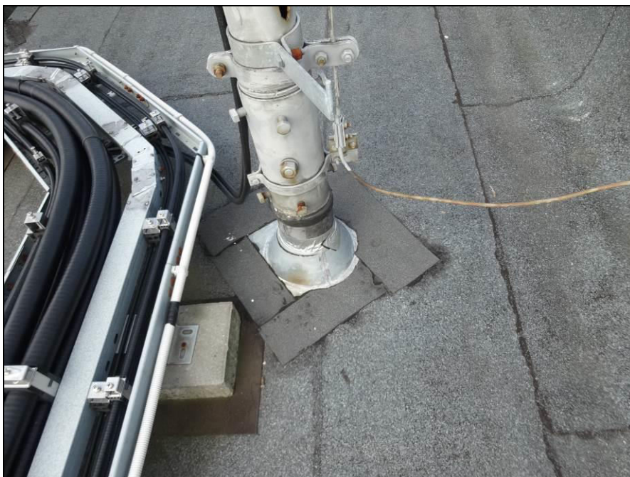
Obr.8 – typický pohled na průraz převisem střechy pro tyčový stožár, shora. Ne zcela systematické provedení utěsnění prostupu.
