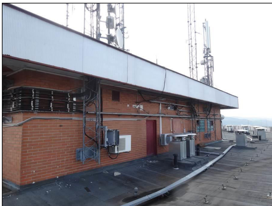
Obr.1 – pohled západní stěny střešní nástavby, s konzolovým převisem střechy, kterým prochází anténní nosiče kotvené do obvodového pláště.
