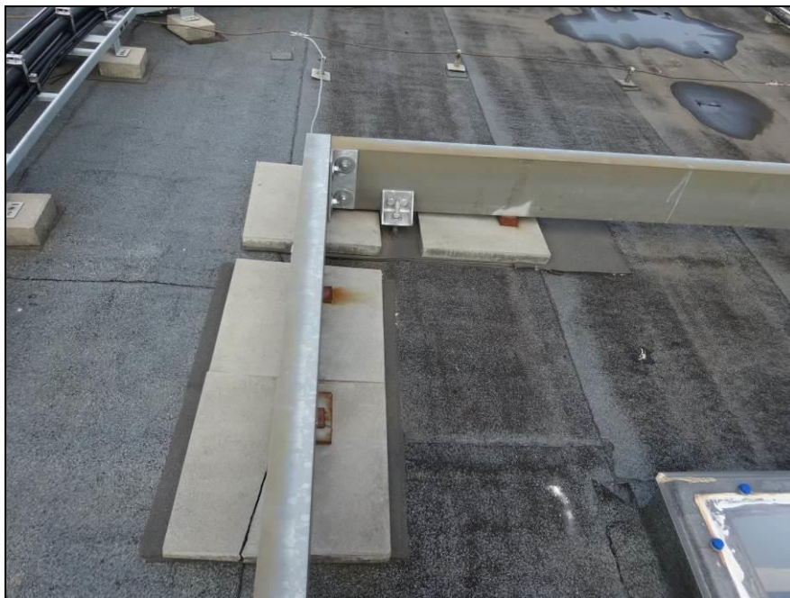
Obr.10 – typický detail uložení SAN – betonové podkladce, do výšky vyrovnané ocelovými podložkami, kladené prostě na zájmovou konstrukci. Na snímku je názorně patrné porušení podkladce. V místě šipky je zobrazena kotva ze závitové tyče, k rámu přichycena příložkou.
