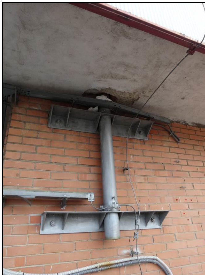
Obr.6 – typický pohled na průraz převisem střechy pro tyčový stožár, včetně názorného poškození spodního líce střechy záteky, olupy a mrazem; mechanické poškození.
