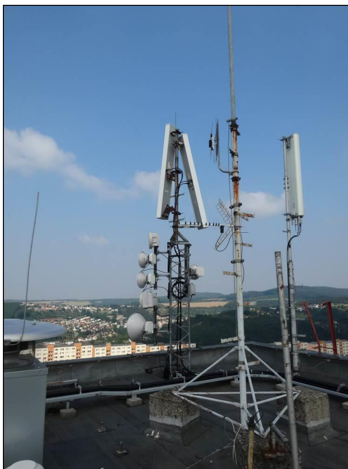
Obr.3 – pohled na původní domovní anténní stožár, uložený na trojici betonových bloků.
