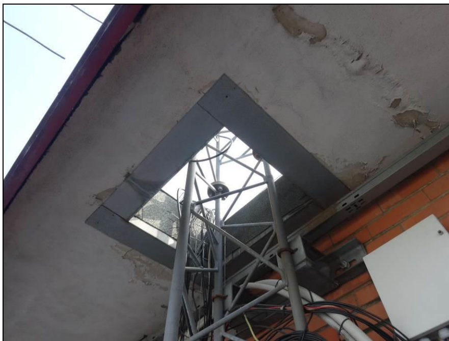
Obr.4 – typický pohled na průraz převisem střechy pro příhradový třístěnný stožár, včetně názorného poškození spodního líce střechy záteky.
