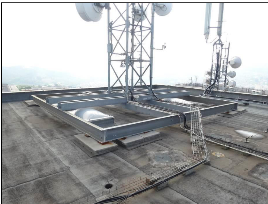
Obr.9 – pohled na osazení SAN na zájmové konstrukci – ocelový rám, s nosným křížem, na kterém je osazen samotný 15 m vysoký sdružený anténní stožár. Nosný rám zároveň překlenuje 2 střešní světlíky.
