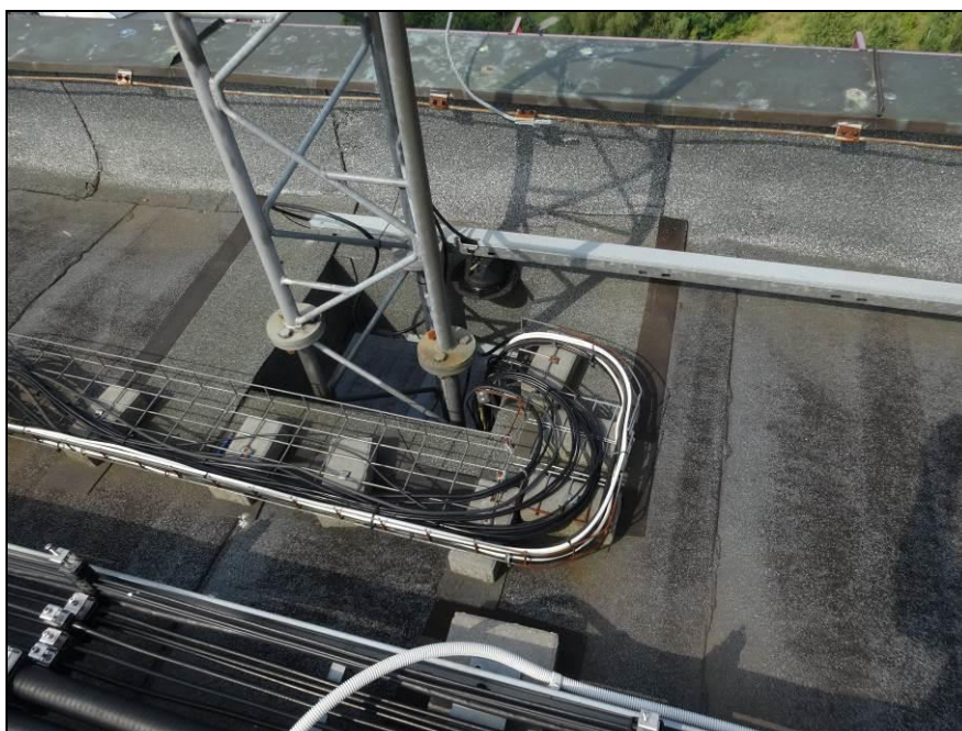
Obr.7 – typický pohled na průraz převisem střechy pro příhradový tříštěnný stožár, shora.
