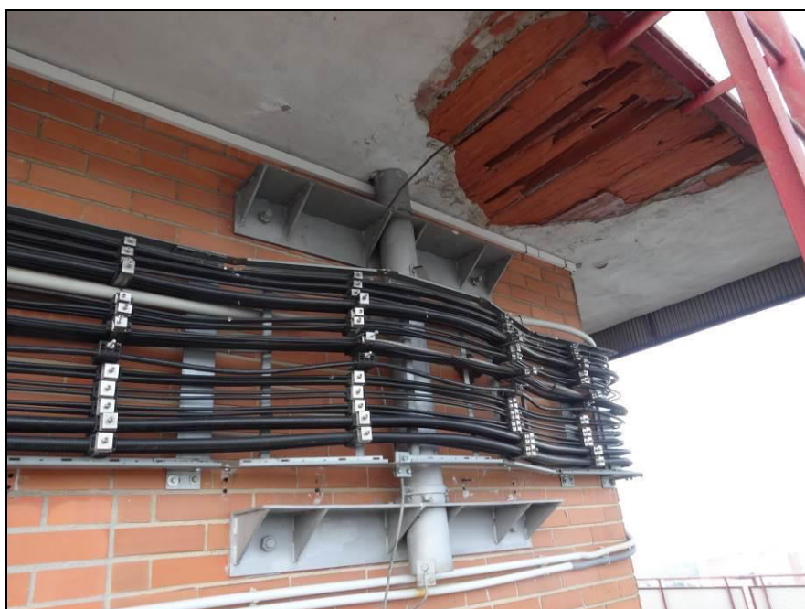
Obr.5 – masivní poškození spodního líce převisu záteky a mrazem – separace a odpadení spodních přírub Hurdis desek.
