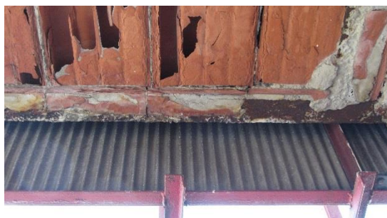
Degradace keramických prvků vystavených klimatickým vlivům.
