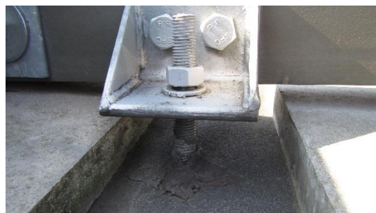
Pohled na uložení základny stožáru v rohu označeném A
