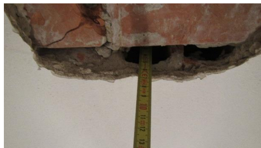
Sekaná sonda S1: Zaměření výšky HURDIS, t=80 mm. V místě sondy byly identifikován stropní systém CSD HURDIS do patek a nosný I profil č. 180.
