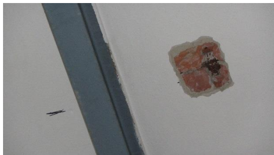
Sekaná sonda S2: Ověření geometrie I profilu
