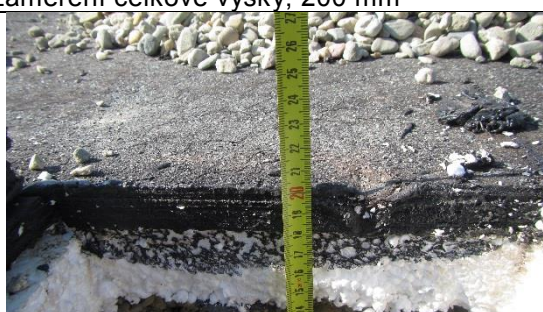
Zaměření izolace, celkem 75 mm
