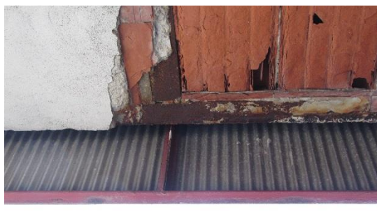
Pohled na napojení ocelového I profilu na obvodový U profil
