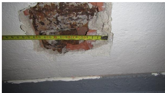
Sekaná sonda S3: Styk I profilů proveden svarovým spojem. V obou směrech identifikován I č.180.
