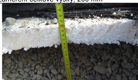
Zaměření izolace, celkem 75 mm
