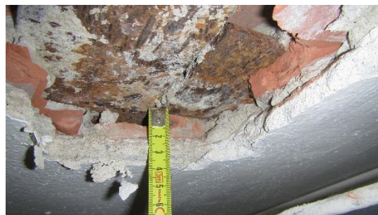
Sekaná sonda S3: V místě sondy byly identifikován stropní systém CSD HURDIS do patek a nosný I profil č. 180
