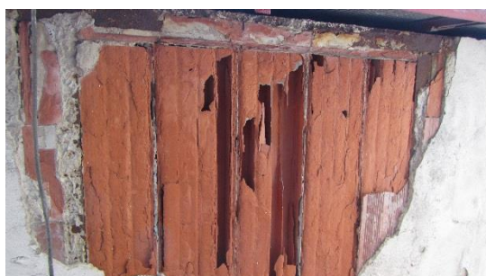
Degradace keramických prvků vystavených klimatickým vlivům.
