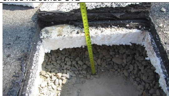
Zaměření celkové výšky, 200 mm
