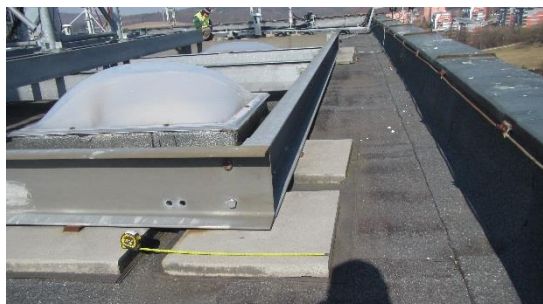
Pohled na uložení základny stožáru v rohu označeném B
