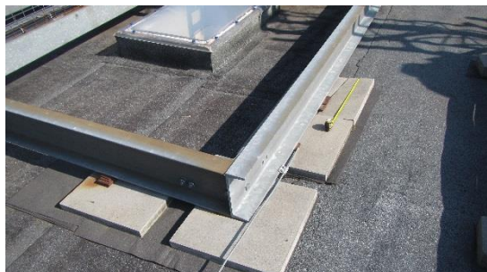
Pohled na uložení základny stožáru v rohu označeném A
