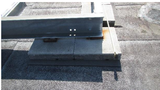
Pohled na uložení základny stožáru v rohu označeném D
