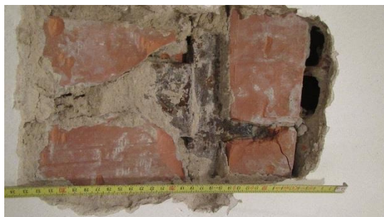
Sekaná sonda S1: Styk I profilů proveden svarovým spojem. V obou směrech identifikován I č.180.
