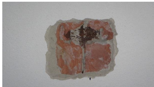
Sekaná sonda S2: V místě sondy byly identifikován stropní systém CSD HURDIS do patek a nosný I profil č. 180.
