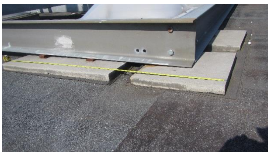
Pohled na uložení základny stožáru v rohu označeném C
