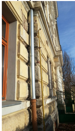
poškozené omítky v blízkosti okapových svodů
