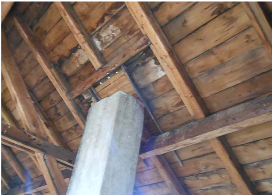
2. ZNÁMKY DŘÍVĚJŠÍHO ZATÉKÁNÍ NA BEDNĚNÍ V OKOLÍ KOMÍNU
