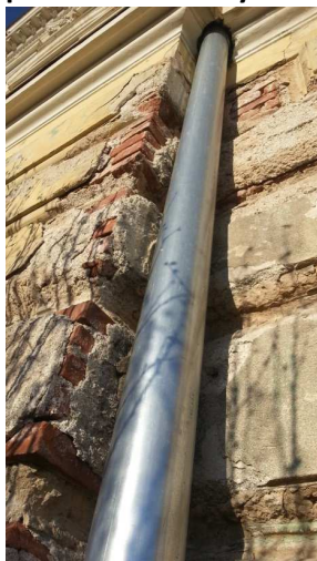
poškozené omítky v blízkosti okapových svodů
