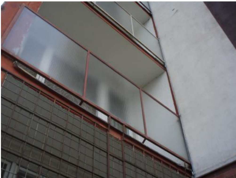
Detail zábradlí lodžii
