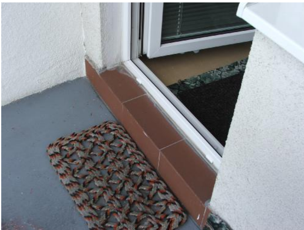
Detail prahu balkonových dveří
