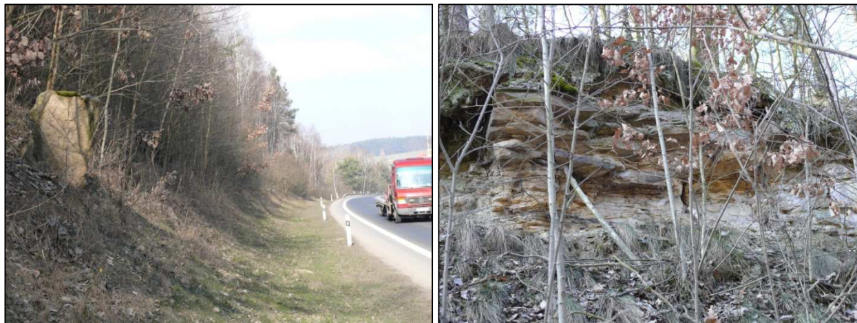
Obr. 1 a 2 – Skalní útvar určený k odstranění a zvětralá stěna skalního zářezu
