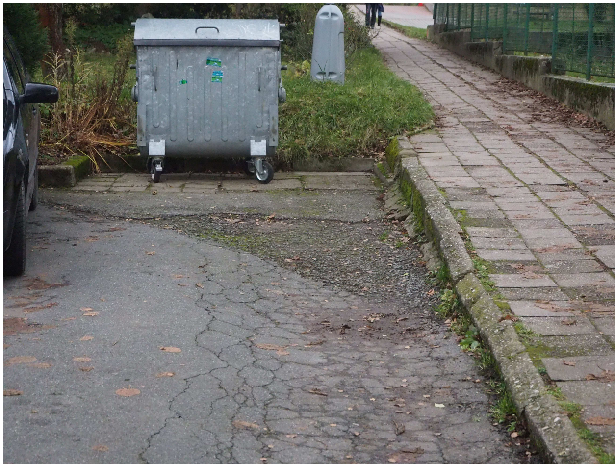
Obr. 3: Úsek chodníku s nestandardní výškou obrubníku.
