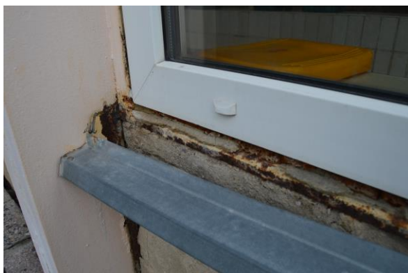
Obr. č.5 – poruchy obvodového pláště
