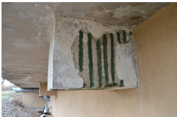
Obr. č.1 – obnažená nosná výztuž
