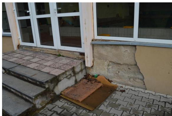
Obr. č.4 – poruchy obvodového pláště
