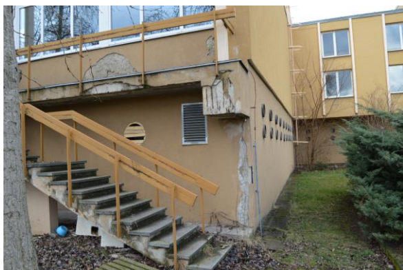
Obr. č.3 – poruchy obvodového pláště
