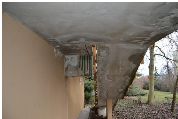
Obr. č.2 – poruchy na venkovní žb. konstrukci
