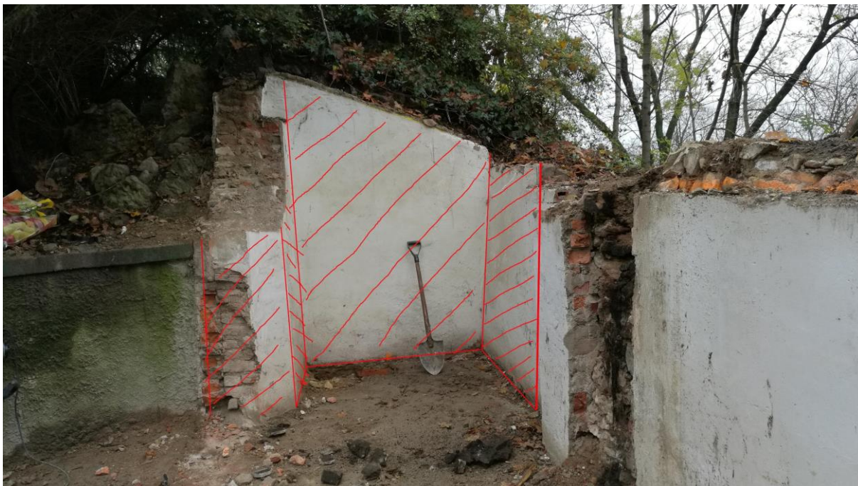
Obr. 1 Pohled za zbývající část demolovaného objektu. Červeně je vyznačena stěna, která bude ponechána.
