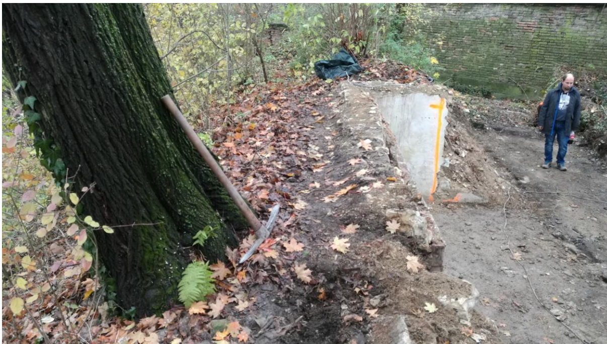
Obr. 2 Násyp za východní obvodovou stěnou demolovaného objektu. Na vrcholu násypu je strom nahnutý směrem ze svahu.
