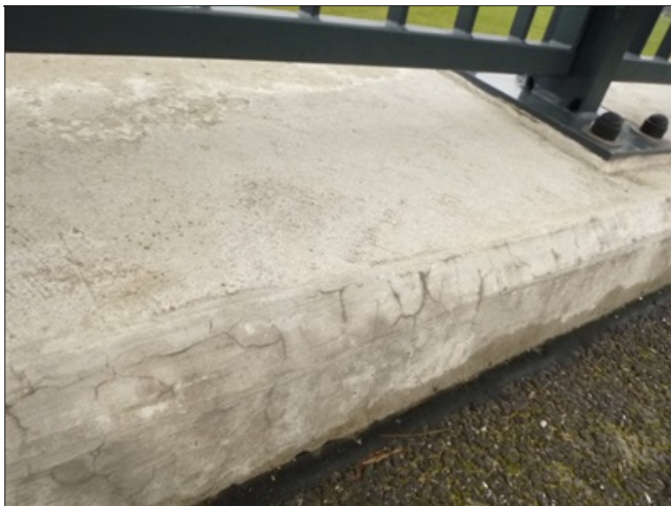
Obrubníková hrana pravé římse
