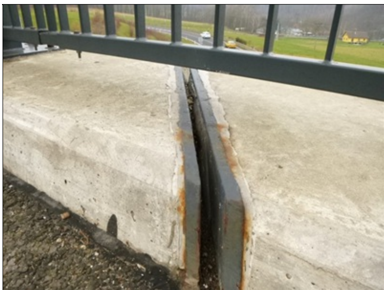
Mostní závěr nad opěrou 2 v pravé římse
