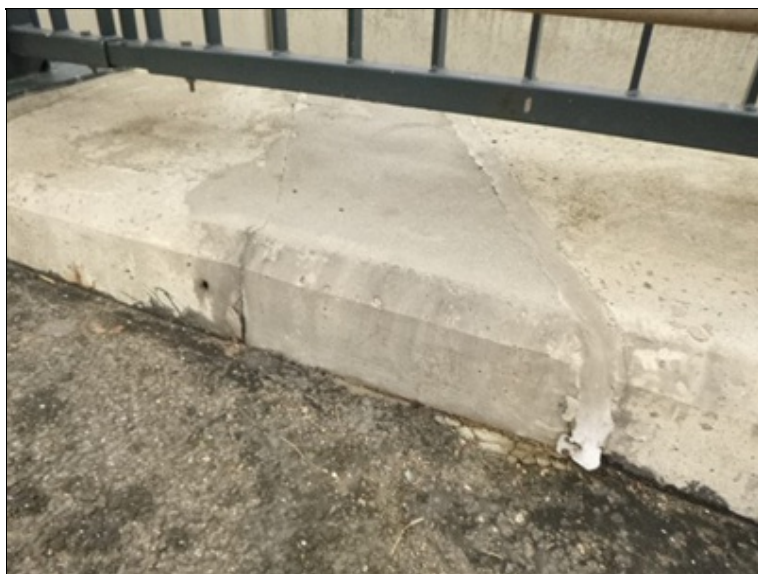
Dilatace v římse vlevo, opěra 1
