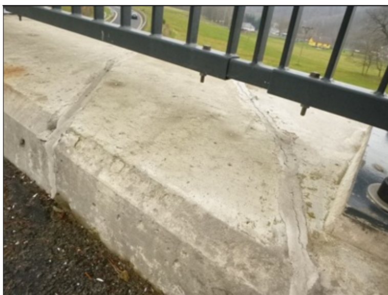
Dilatační spáry v pravé římse nad opěrou 1
