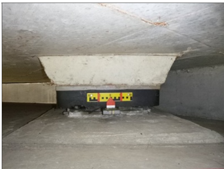
Ložisko a úložný práh opěra 2
