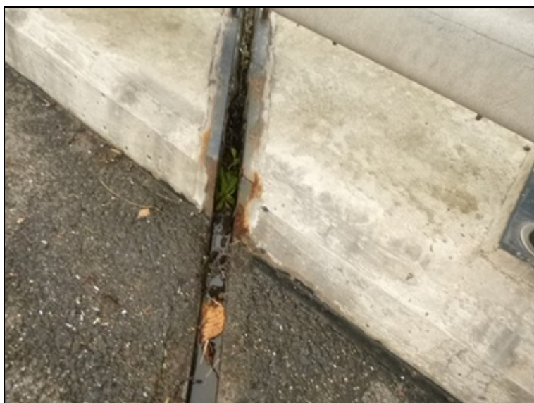
Mostní závěr nad opěrou 2 vlevo
