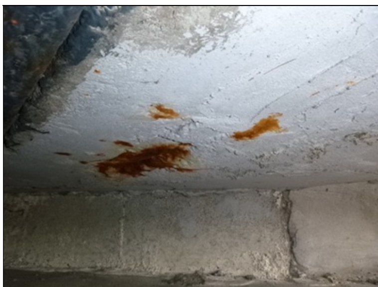
Podhled krajního levého nosníku za uložením na ložisko
