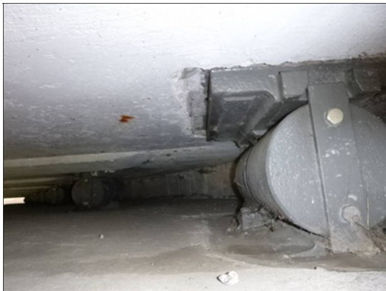
Ložisko opěra 2 pod krajním nosníkem vpravo
