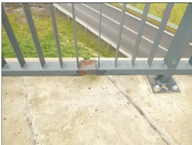
Koroze zábradlí
