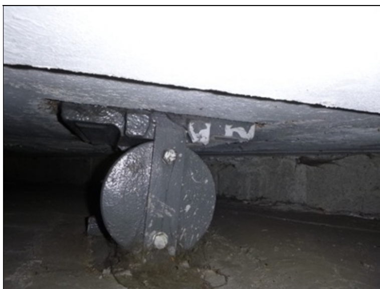
Ložisko na opěře 2 pod druhým nosníkem zprava
