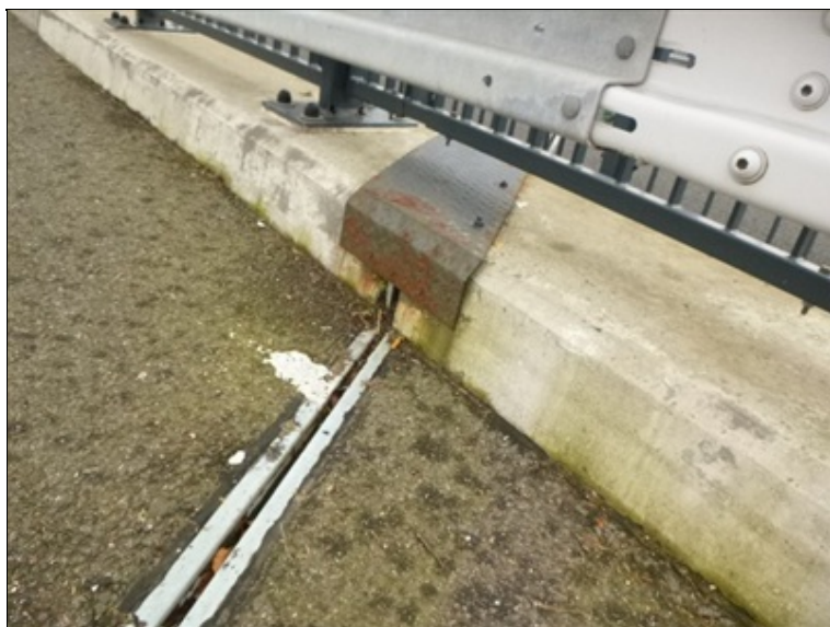
Mostní závěr nad opěrou 2 vpravo
