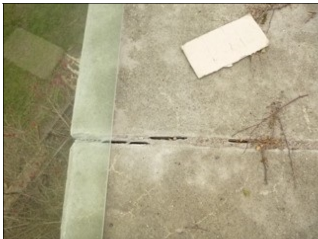
Dilatační spára mezi křídlem mostu a opěrnou zdí vpravo.
