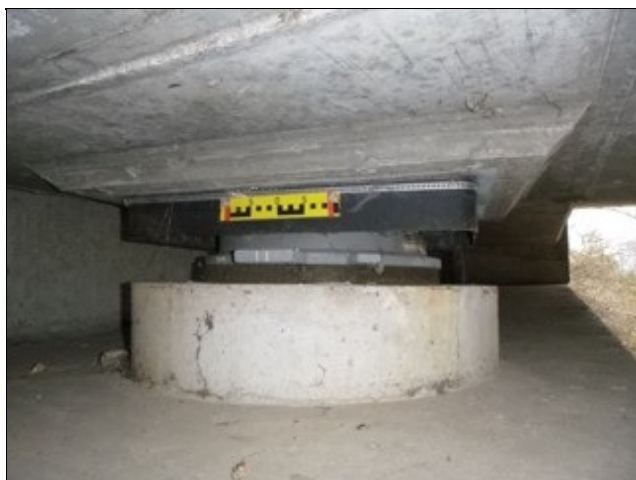
Levé ložisko na opěře 1
