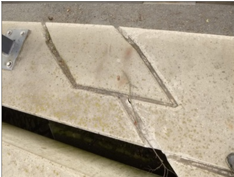
Dilatační spára v římse nad opěrou 1
