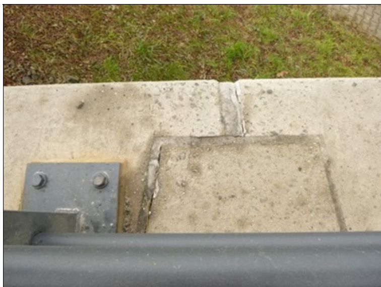
Dilatační spára v římse
