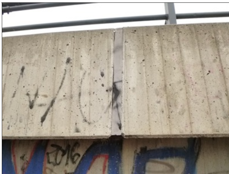
Dilatační spára v římse nad opěrou 2 vpravo
