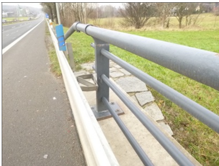
Uvolněná krabice svod. zábradlí vlevo
