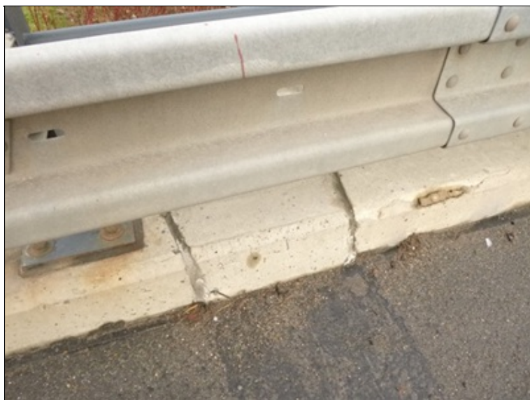
Dilatace v římse nad opěrou 1 vlevo
