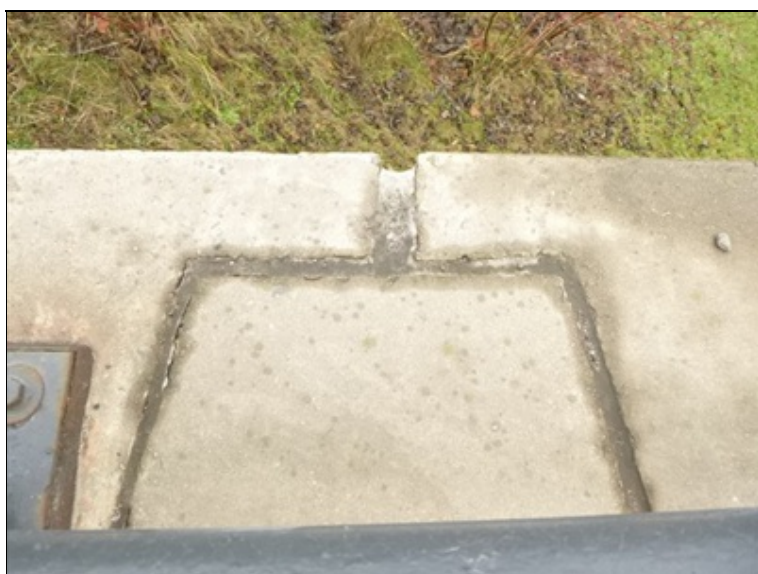
Dilatace v římse nad opěrou 1 vlevo
