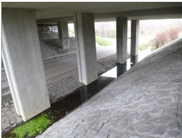
Odvodnění u piliře 02
