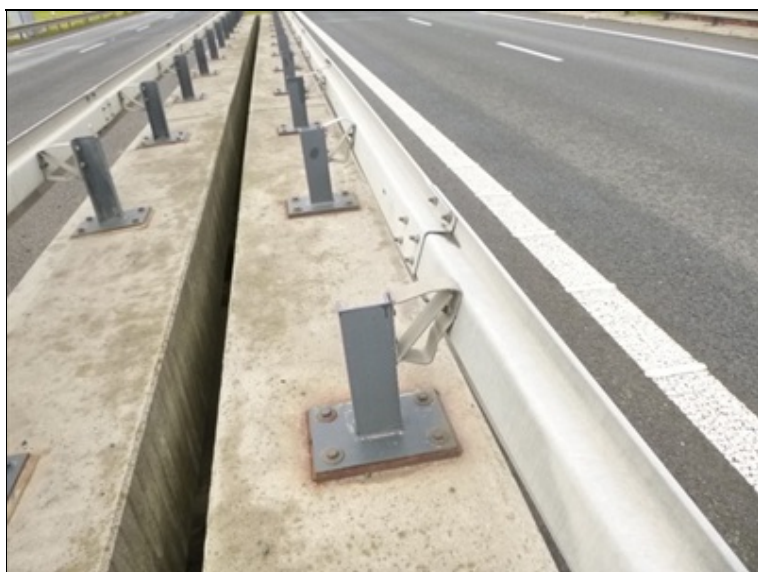
Deformace svodidla vpravo před opěrou 2
