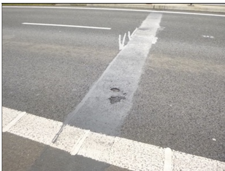
Výtluk v mostním závěru nad opěrou 2
