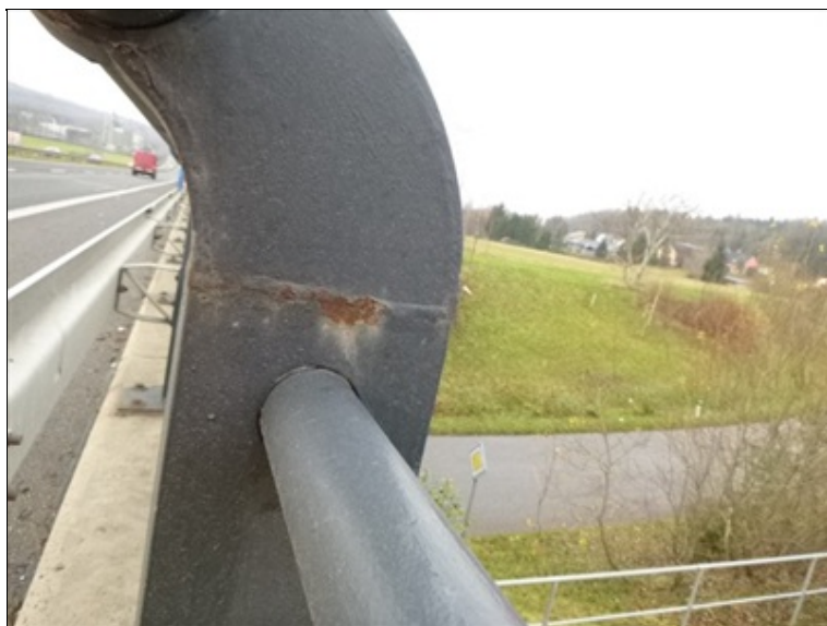
Koroze sloupku svodidlového zábradlí vlevo
