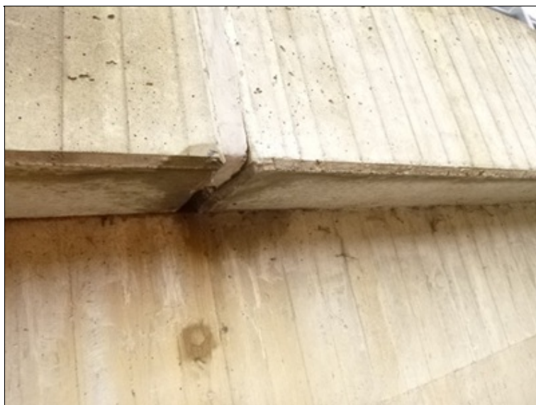
Dilatační spára v římsě nad opěrou 1
