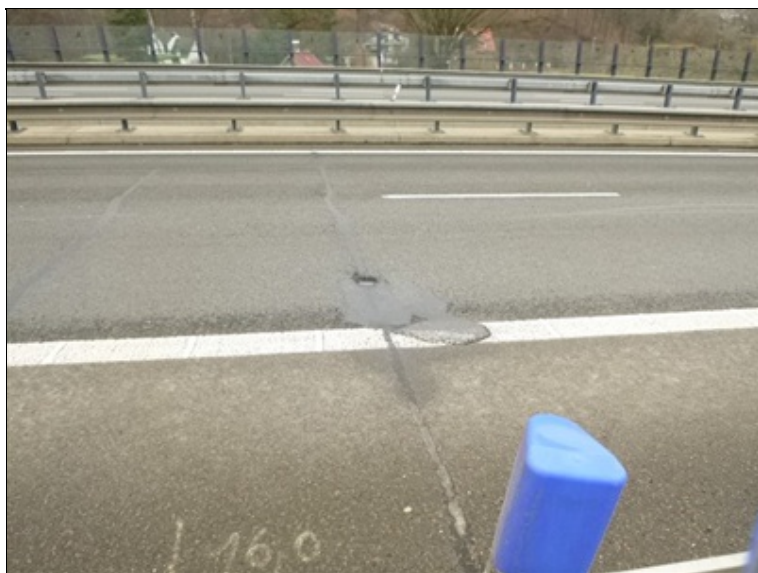
Výtluk ve vozovce ve středním poli
