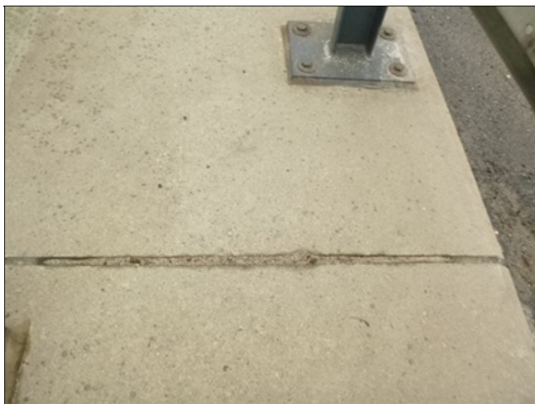
Dilatační spára v chodníku vlevo
