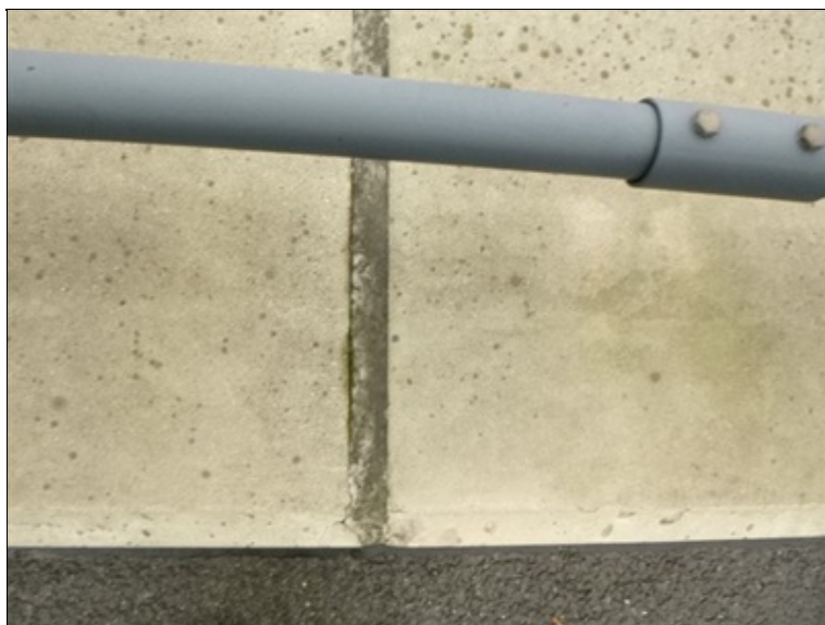
Dilatační spára v římse
