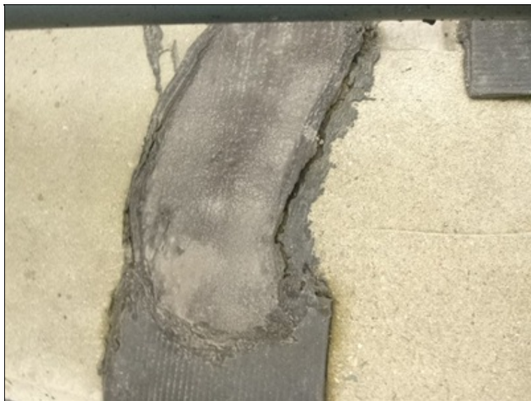
Zatěsnění dilatační spáry v římsě vpravo nad opěrou 01
