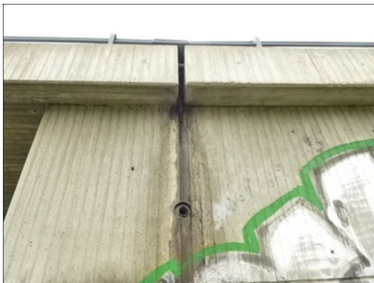
Levé křídlo u opěry 1- dilatační spára v římse
