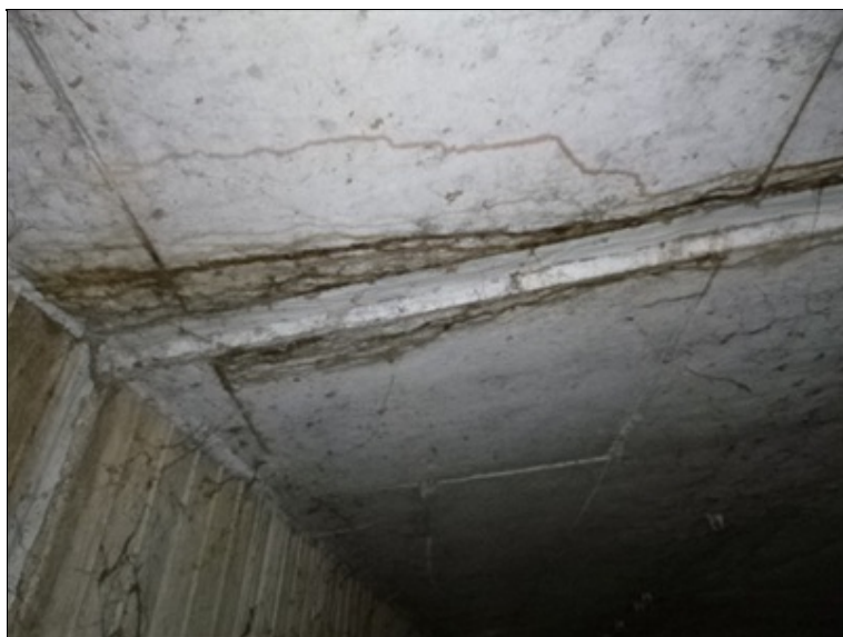
Spára s průsaky
