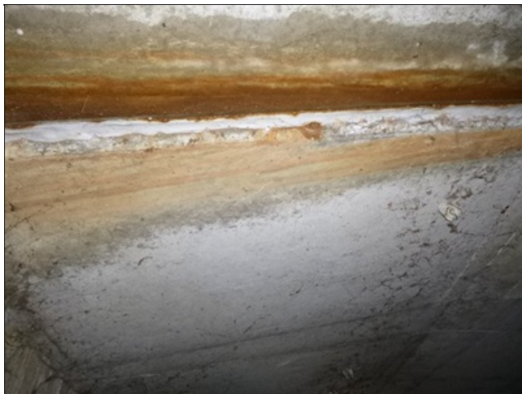
Spára s průsaky
