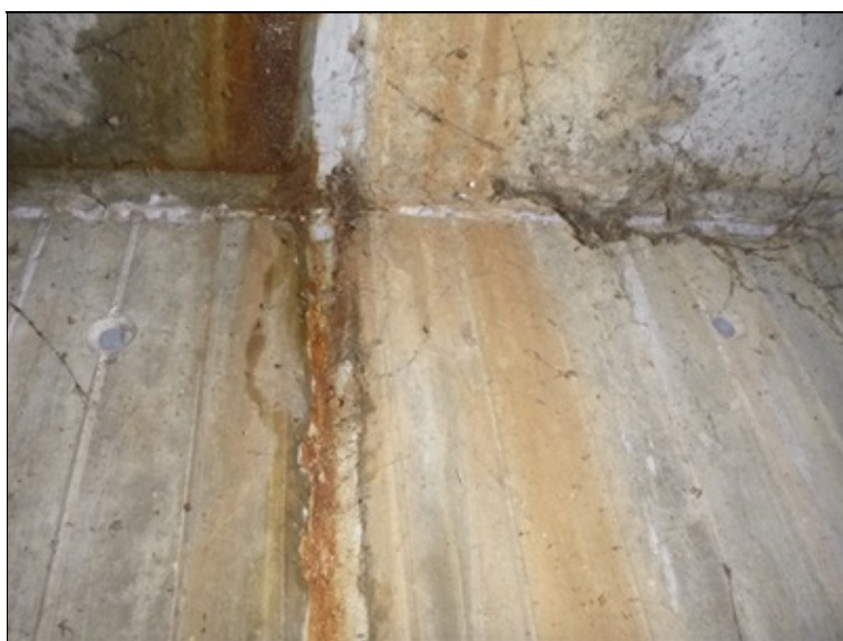
Spára s průsaky
