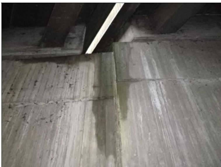
Zatékání na úložný práh.
