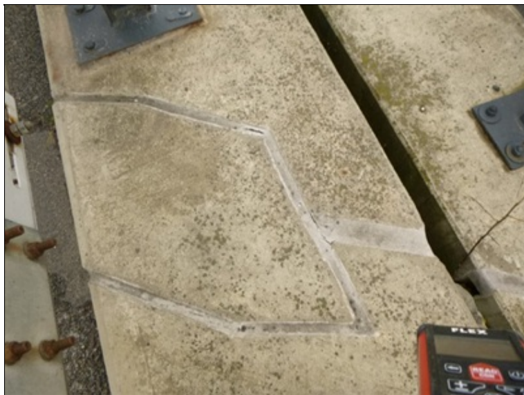
Dilatace v římsě nad opěrou 3 vlevo
