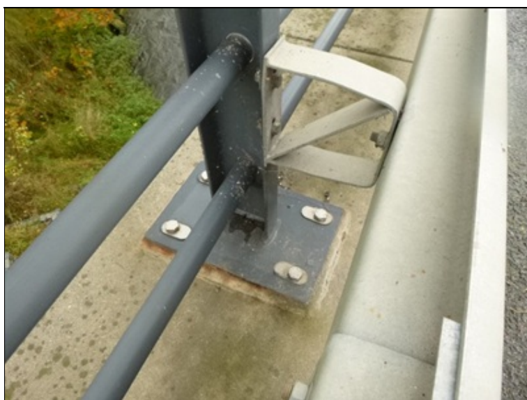
Patní deska zábradlí
