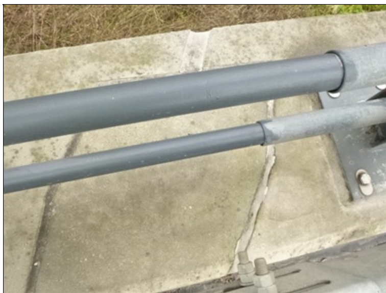
Dilatační spára v římsě nad opěrou 2
