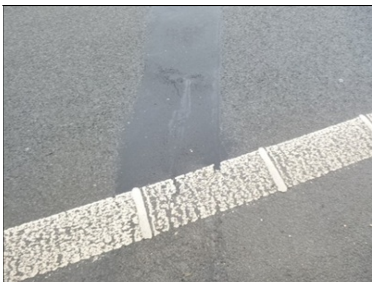
trhliny v EMZ nad opěrou 2
