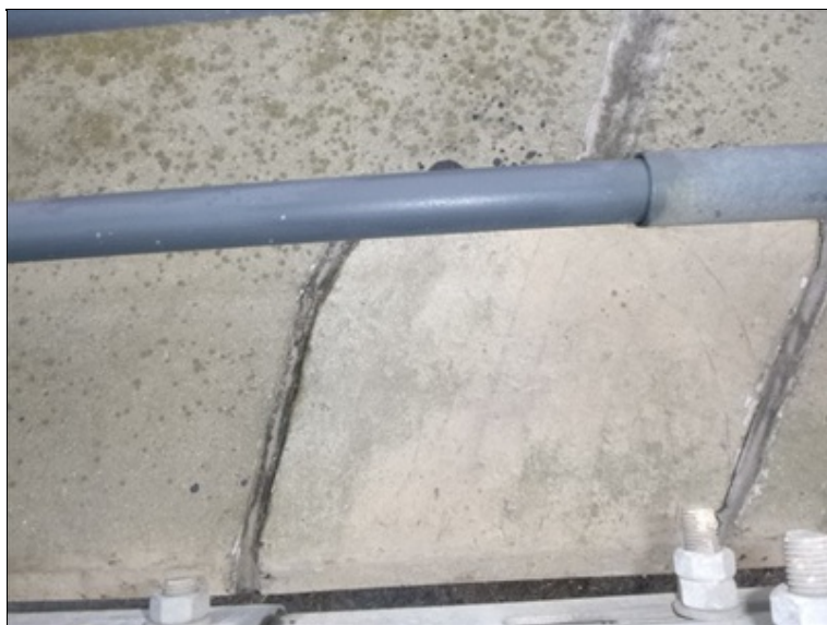
Dilatační spára v římsce nad opěrou
