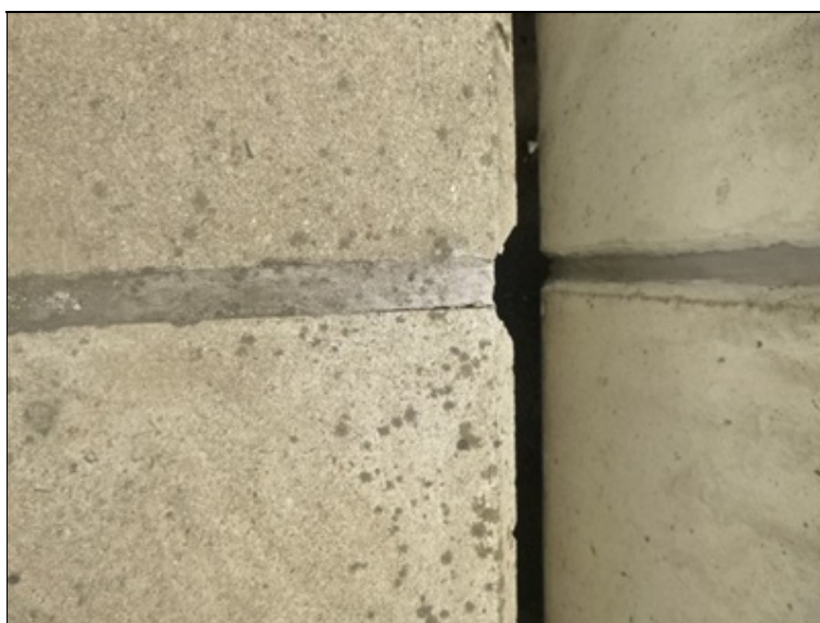
Dilatační spára v římse vlevo.
