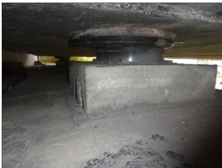
Levé ložisko na opěře O4
