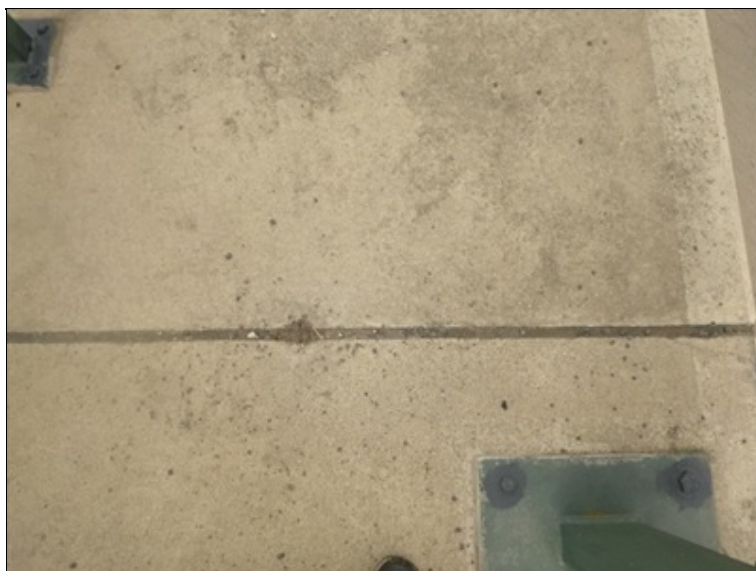
Dilatační spára v betonu chodníku
