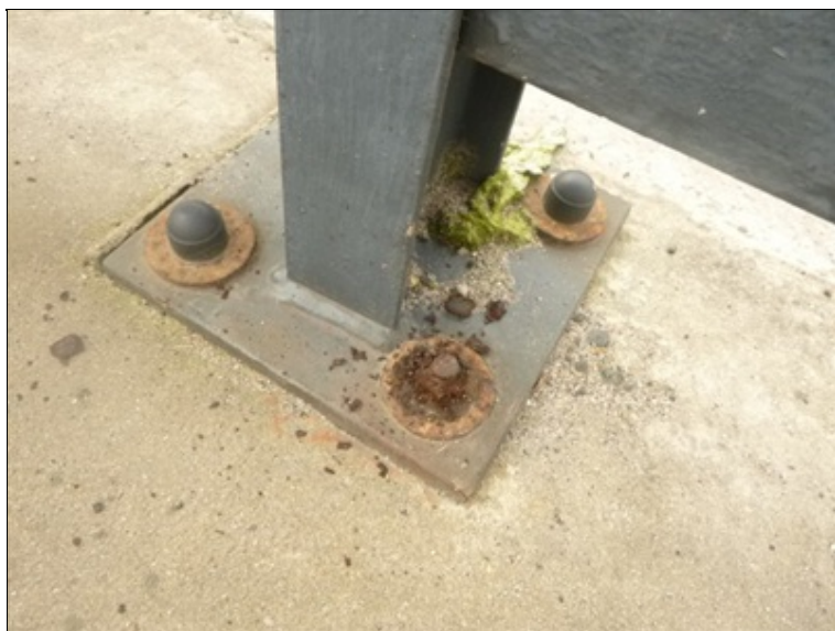
Patní deska sloupku zábradlí
