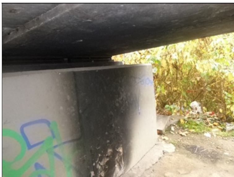
Opěra O4 vpravo- povrch betonu poškozen ohněm.
