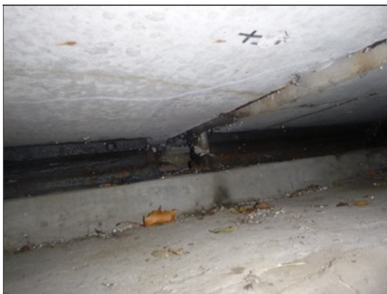
Ložiska na opěře O4
