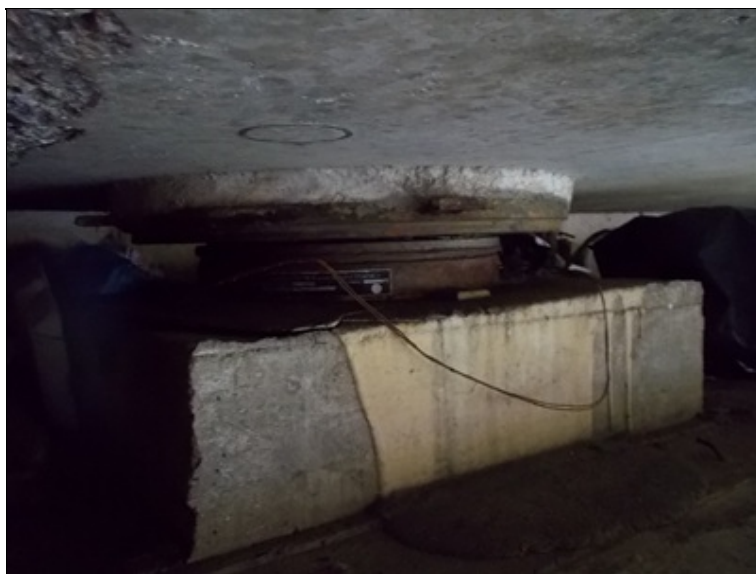
Odpadky na úložném prahu opěry 04 vlevo
