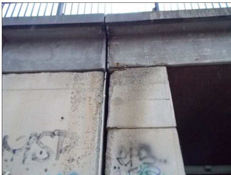
Dilatační spára vpravo mezi křídlem a opěrou 1
