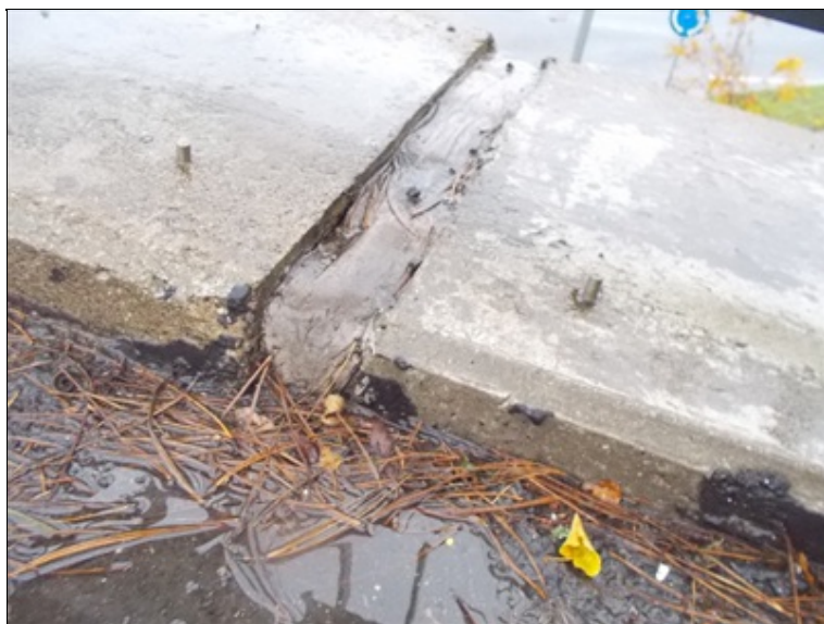
Dilatační spára v římse mezi nosnou konstrukcí a křídlem
