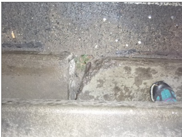
Uražená hrana římsy vlevo.
