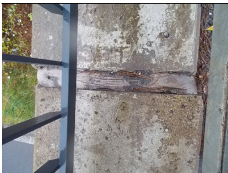
Dilatační spára v římse mezi opěrou a křídlem
