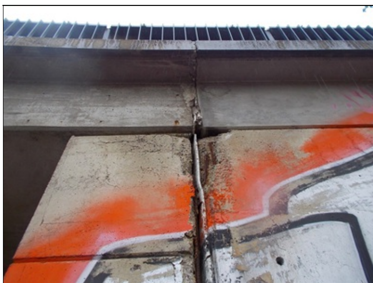
Dilatační spára vpravo mezi křídlem a opěrou 2
