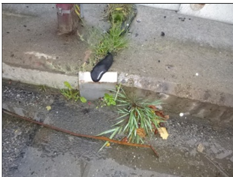
Dilatační spára v římse
