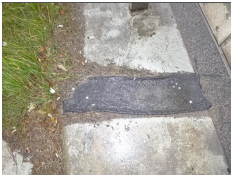
Dilatace v levé římse
