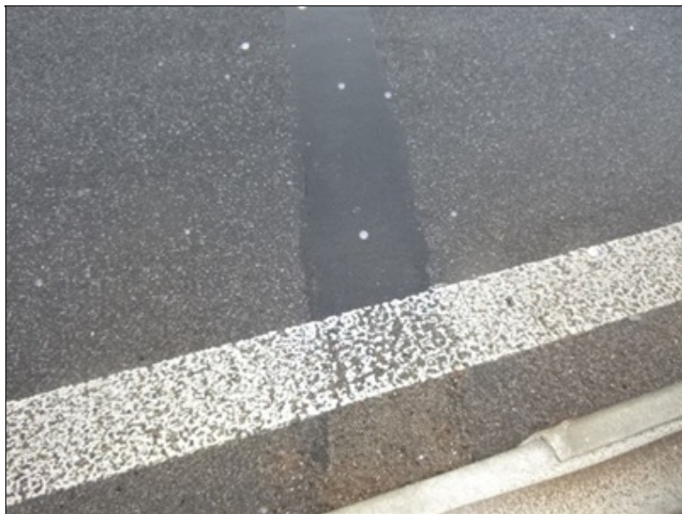
Dilatace nad opěrou 2 vlevo
