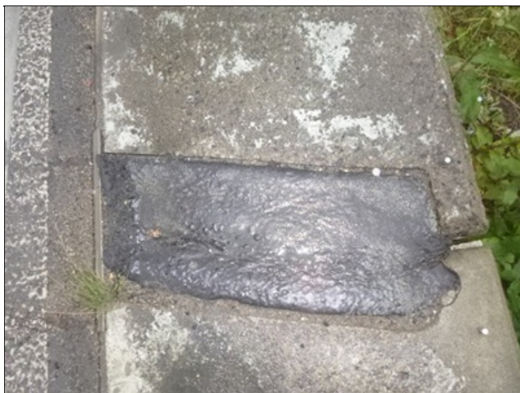
Těsnění dilatačního závěru na pravé římse
