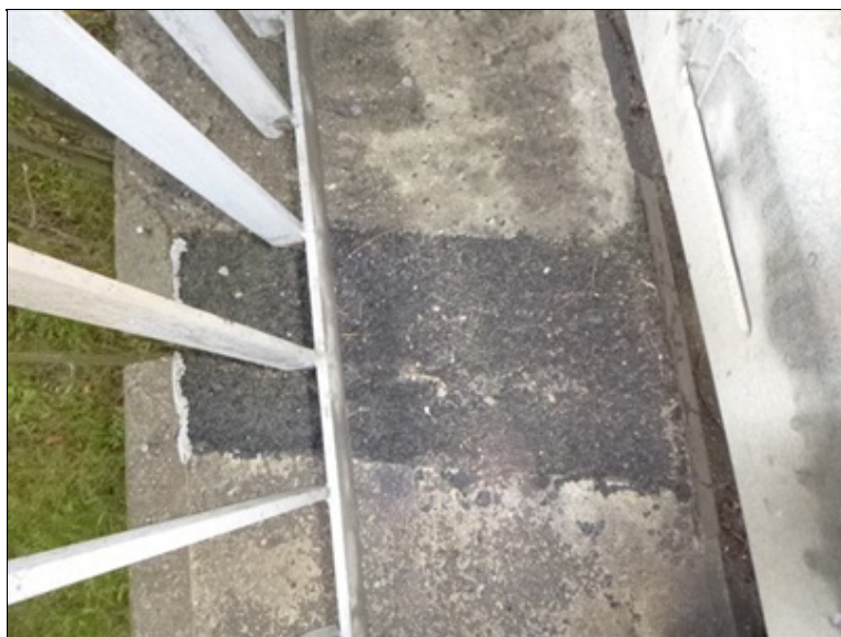
Těsnění dilatace v pravé římse
