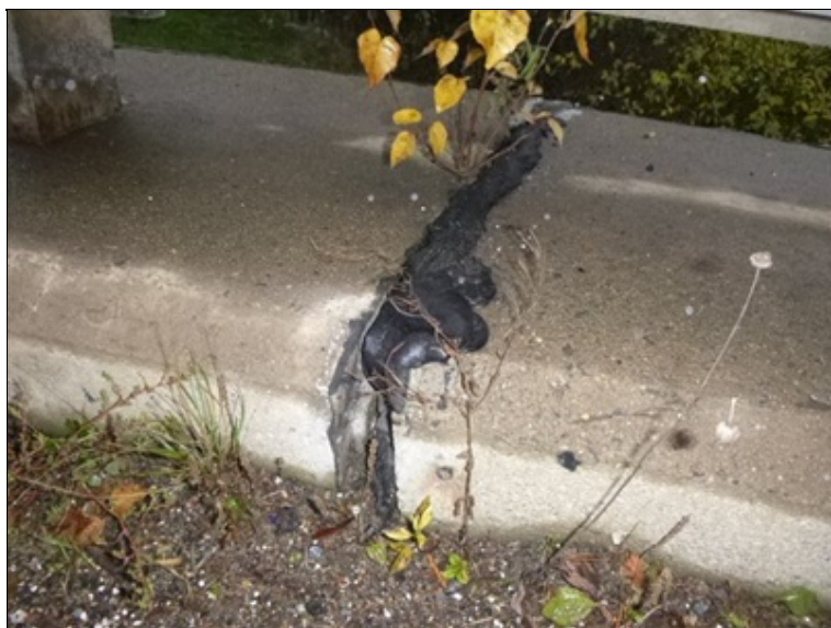
Dilatační spára v římse vlevo
