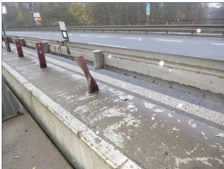
Deformace sloupku svodidla
