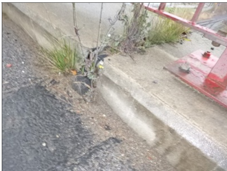
Dilatační spára v římse
