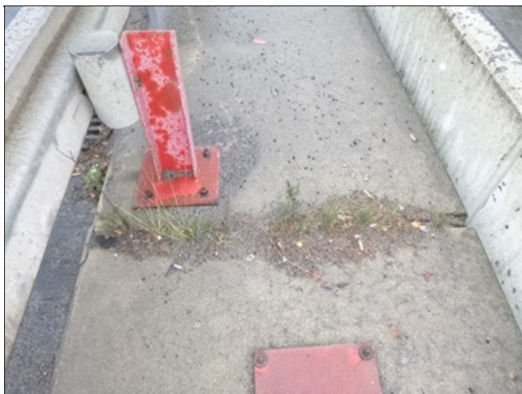
Dilatační spára v římse vpravo
