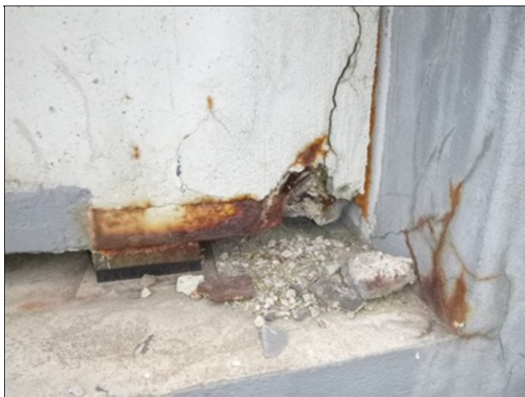
Uložení nosníku na úložný práh opěry 1
