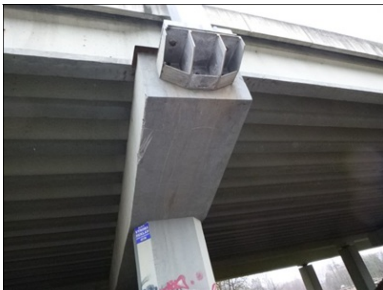
Kotvení portálu na pilíři 11
