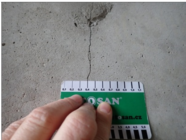
Smršťovací svislá trhlina v opěře
