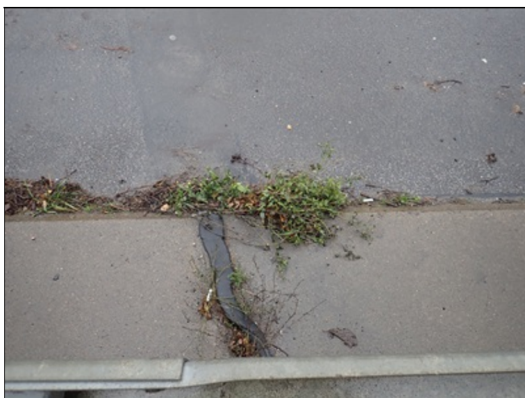
Dilatace v římse vpravo a zakořeněná vegetace ve spáře podél římsy
