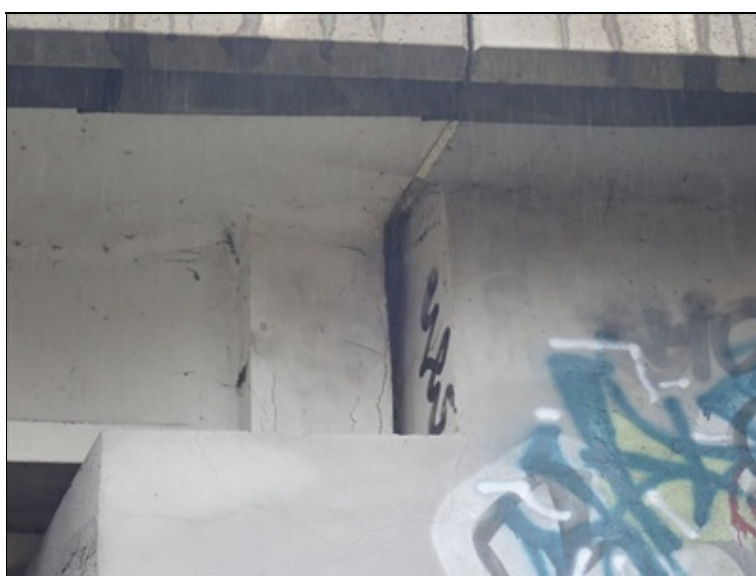
Trhliny v koncovém příčnicku
