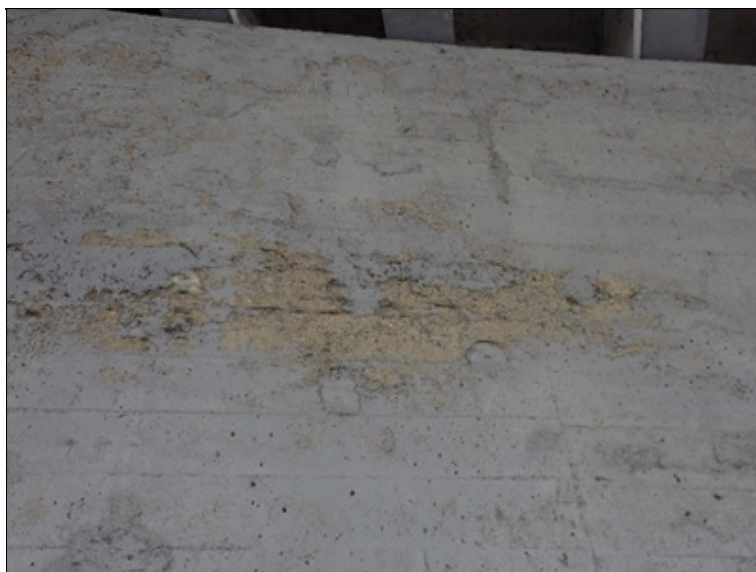
Poškozený nátěr 1.opěry
