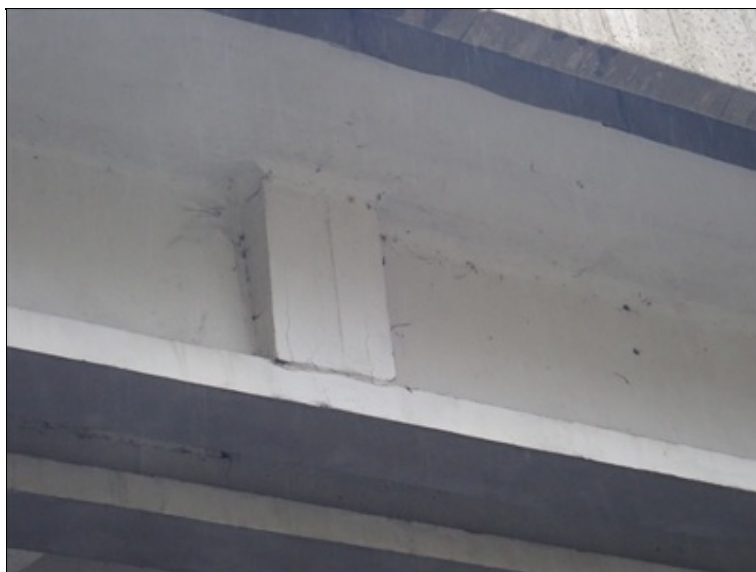
Trhlina v boku mezilehlého příčníku
