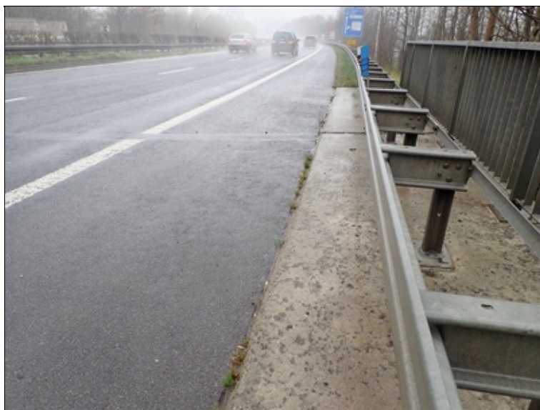
Vegetace podél římsy vlevo
