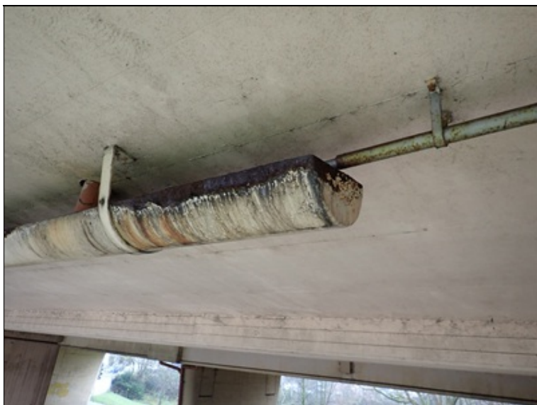
Ocel. odvodňovací žlab pod podhledem NK
