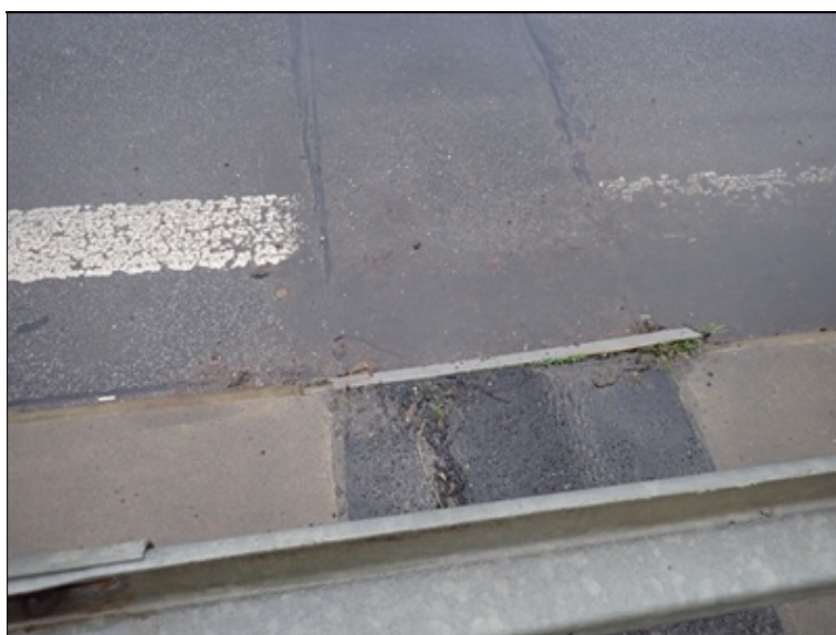
EMZ a kaluže podél římse vpravo
