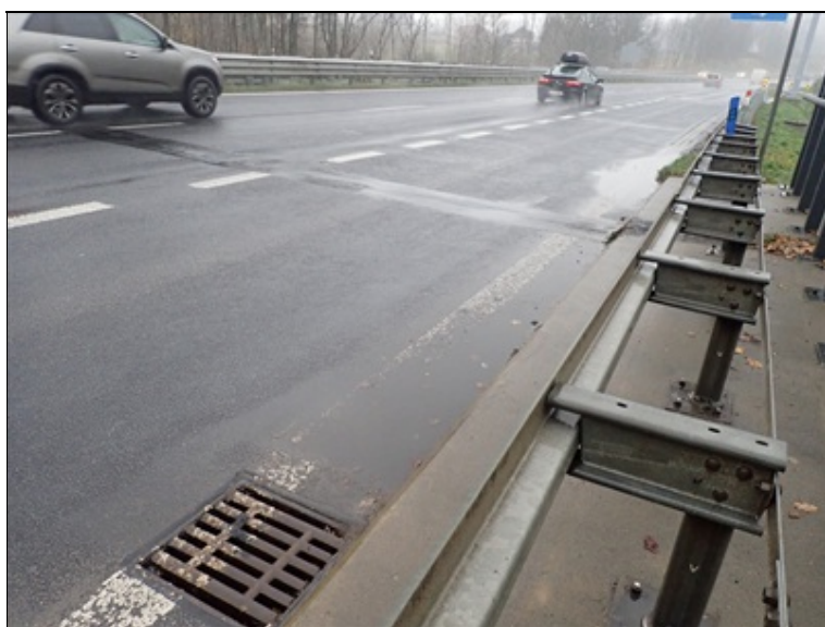
špatné vyspádování krajnice podél římsy vpravo
