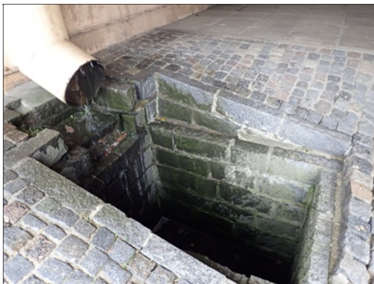
Jímka pro vyústění odvodnění u 1.opěry
