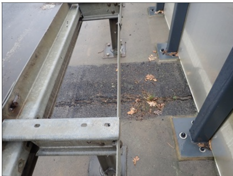
Dilatace v římse vpravo nad 1.opěrou
