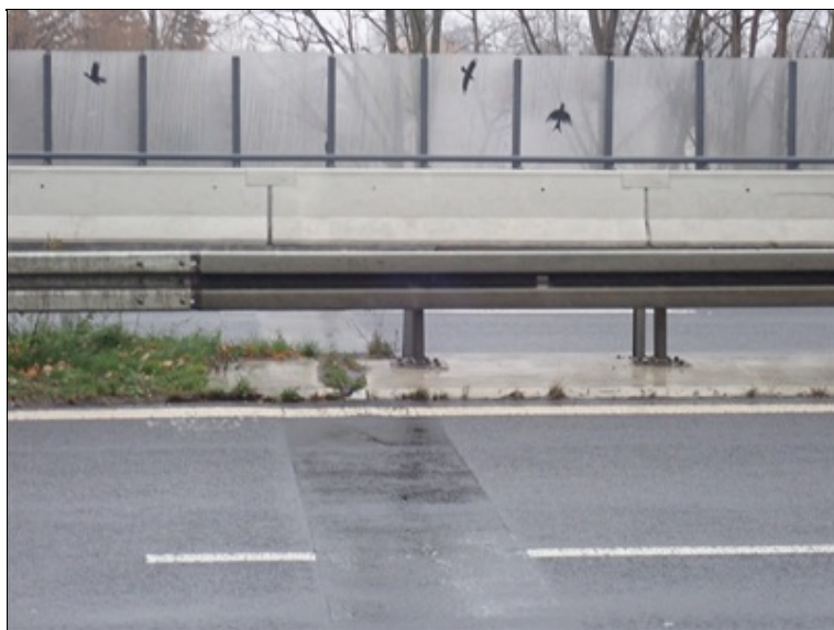
EMZ nad 1.opěrou a římsa vlevo
