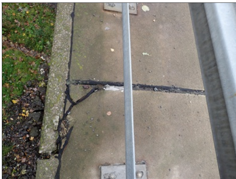
Dilatace v římse vpravo
