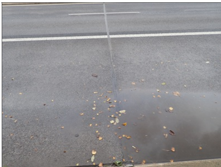
Řezaná spára nad 1.opěrou a kaluže podél římsy
