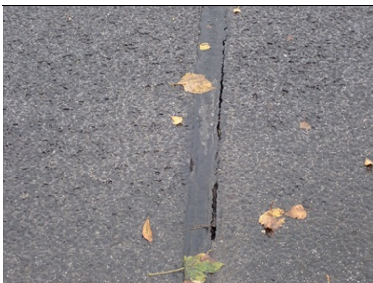
Detail poškozené výplně řezané spáry nad 2.opěrou
