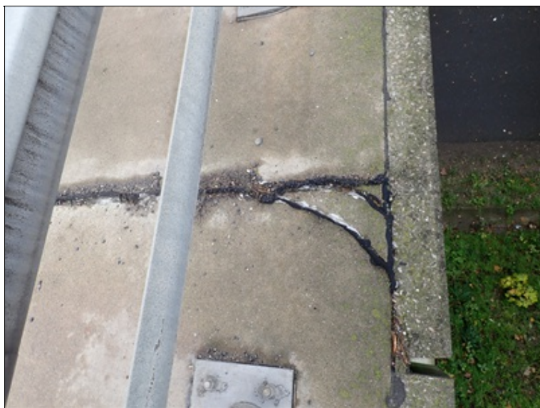
Dilatace v římse vlevo
