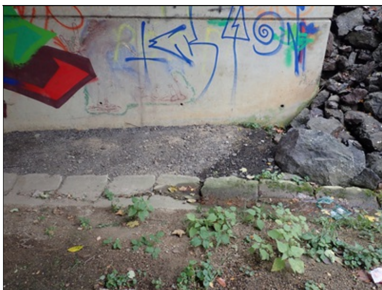
Bet. žlabovky pod mostem u 2.opěry vpravo.
