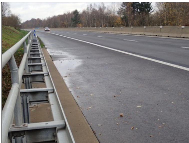
Kaluže u římsy vpravo v místě 1.dilatace
