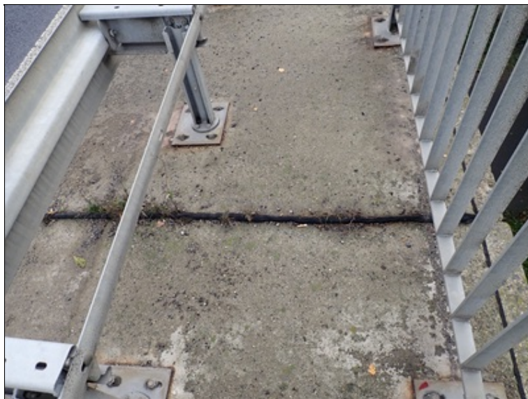
Dilatace v římse vpravo
