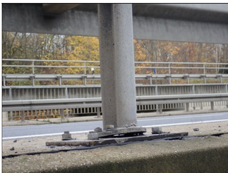
Poškozené kotvení zábradelního sloupku vlevo
