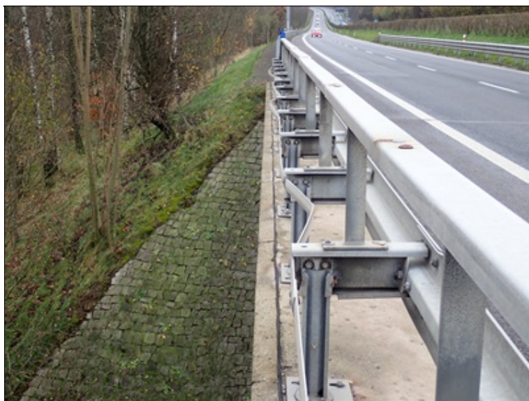
Deformované prvky zábradelního svodidla vlevo
