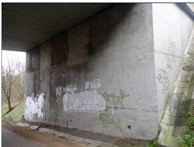
Pohled na 2.opěru a poškozené bet. žlabovky.
