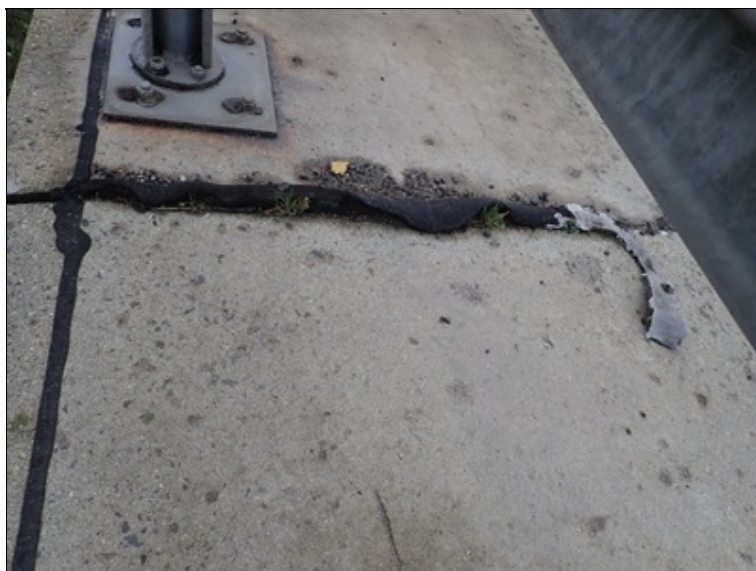
Dilatace v římse vlevo
