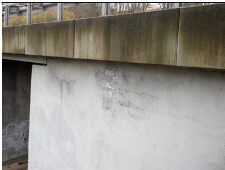
Vápenné výluhy na 1.křídle vlevo
