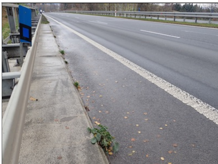
Spára mezi vozovkou a římsou vpravo
