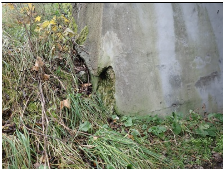
Degradace betonu paty 2. opěry vlevo
