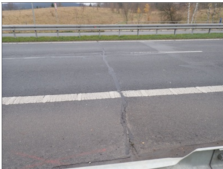
Otevřená spára ve vozovce za 2. opěrou vlevo
