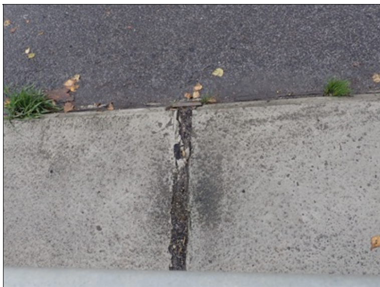
dilatace v římse vpravo nad 2. opěrou
