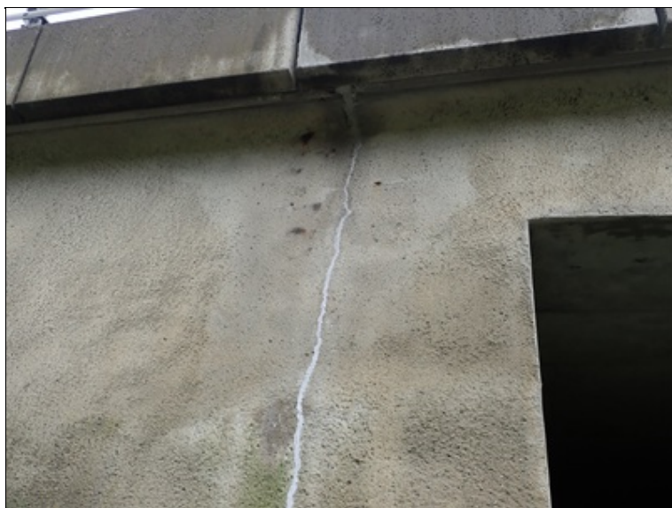
Sanace trhliny u 1. opěry vpravo
