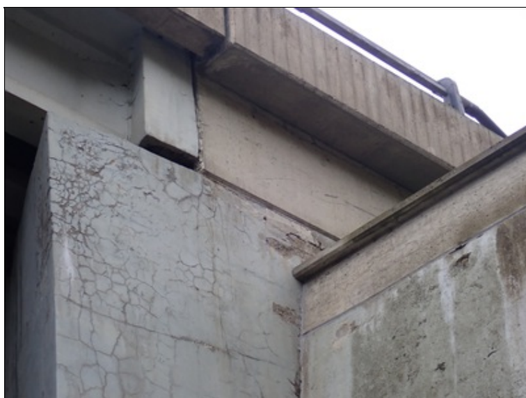
Alkalická reakce kameniva - 2.opěra vpravo
