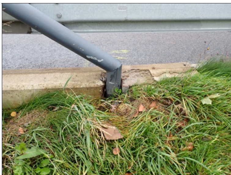
Ukončení madla svodidlového zábradlí
