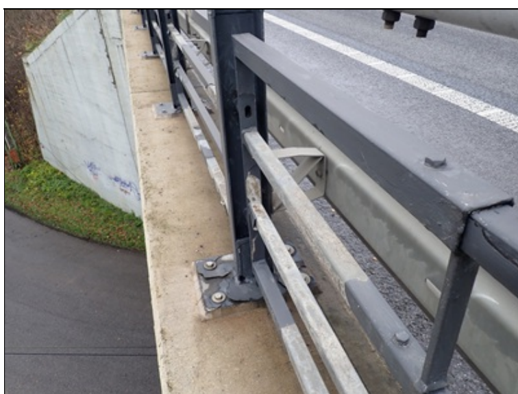
Poškozená PKO svodidlového zábradlí
