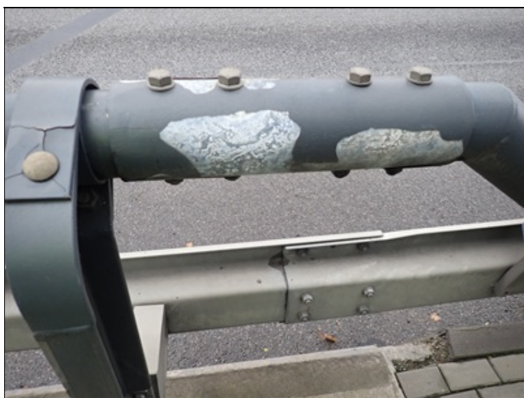
Poškozená PKO zábradelního svodidla
