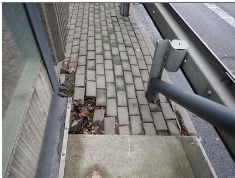
Poškozená dlažba na předpolí za 2.opěrou
