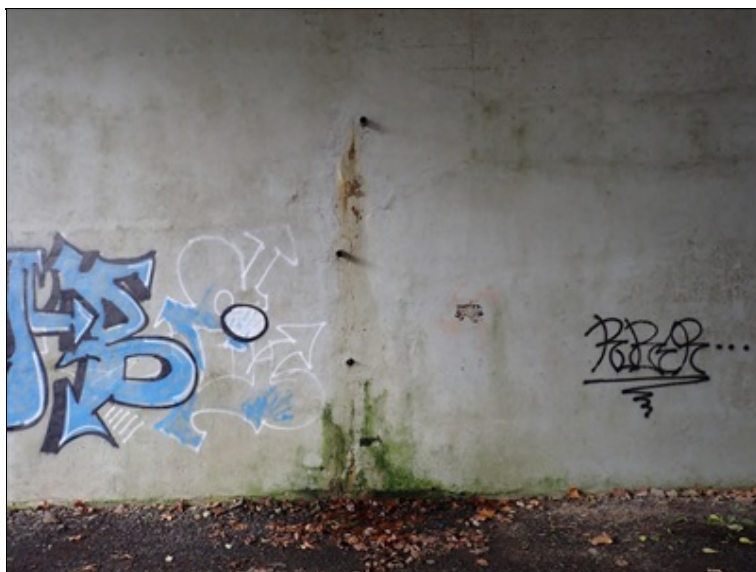
Detail 1.opěry s průsaky
