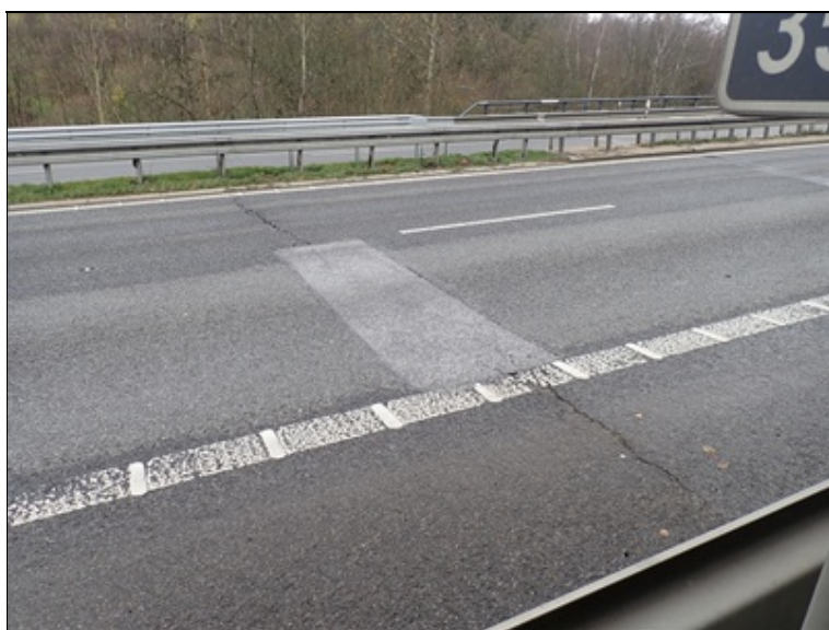
Otevřená trhlina na předpolí za 2.opěrou
