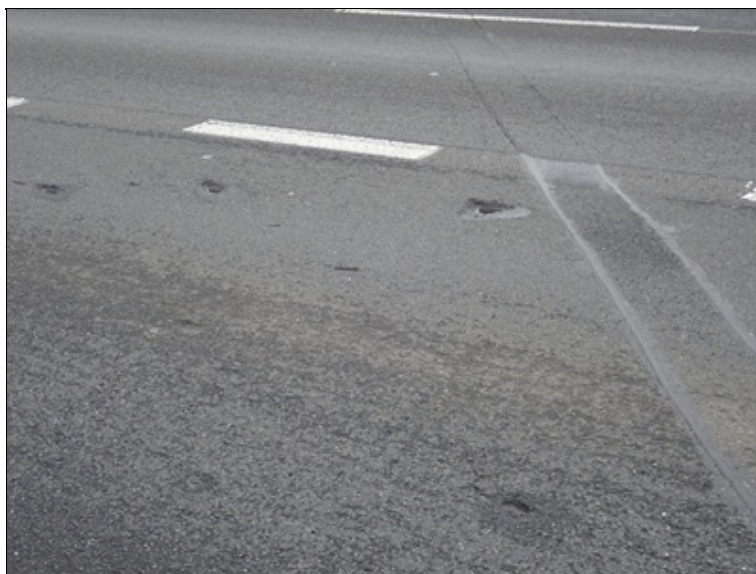
EMZ nad 2.opěrou a lokální výtluky ve vozovce
