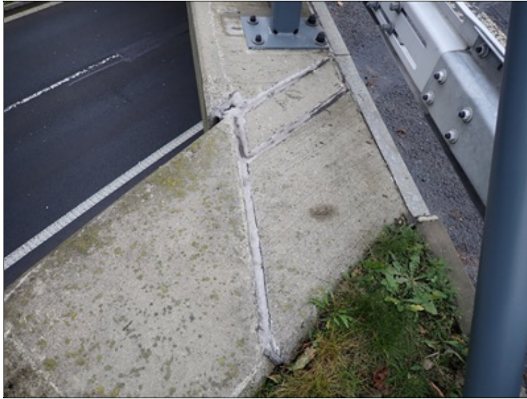
Poškozená dilatace v římse nad 2.opěrou
