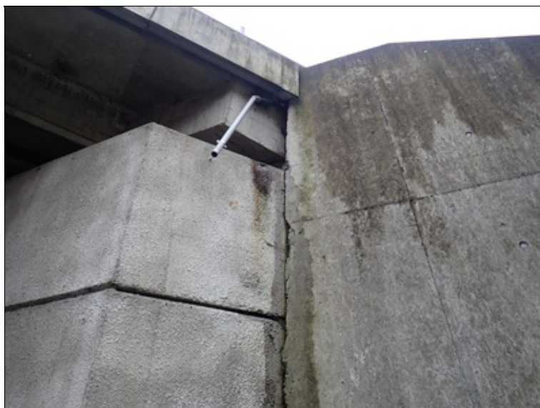
Provhlá spára mezi 2.opěrou a křídlem vpravo
