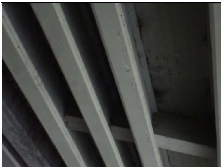
Trhlina v pohledu NK u 10.nosníku zleva
