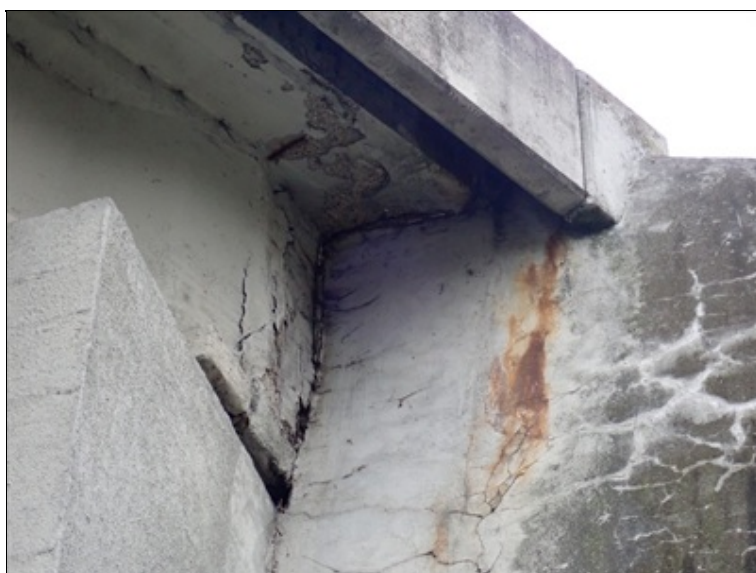
Degradace betonu a obnažená výztuž NK
