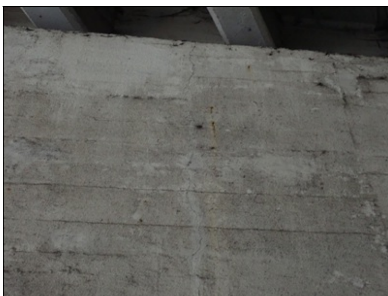
Svislá trhlina v 1.opěře
