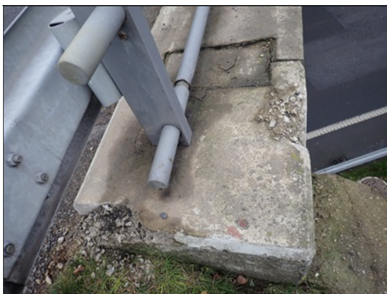
Degradace betonu na konci římso vlevo
