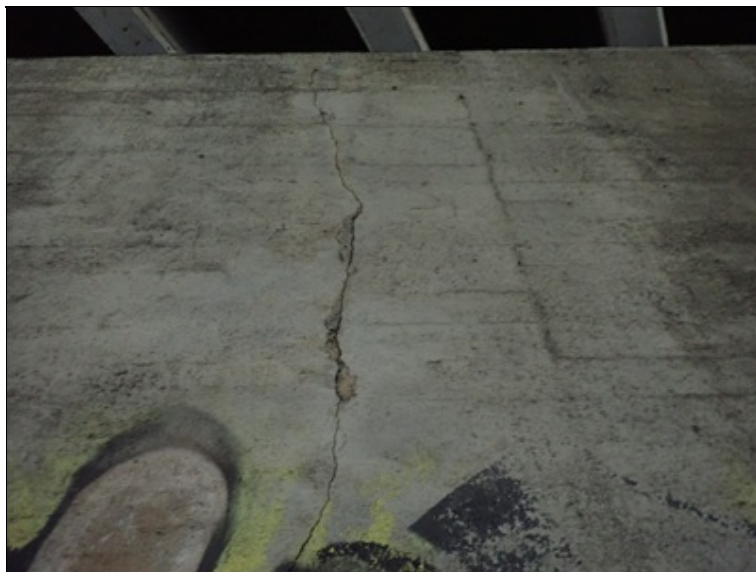
Svislá trhlina ve 2.opěře
