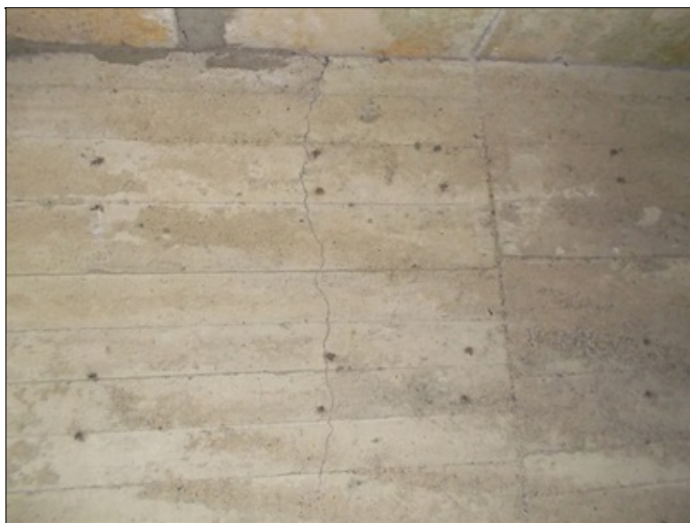
Svislá trhlina v opěře na výtoku
