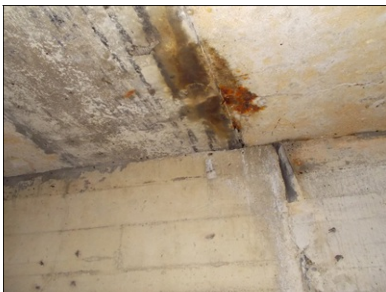
Průsaky v podhledu NK
