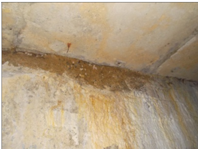
Degradace betonu opěry v místě uložení
