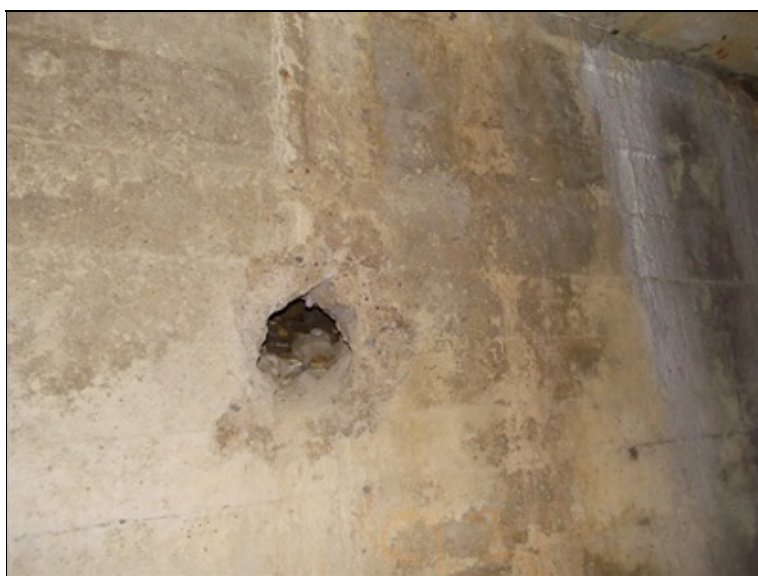
Otvor v pravobřežní opěře
