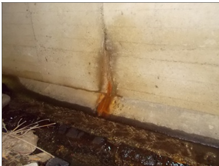
Průsaky v patě opěry zbarvené rzi
