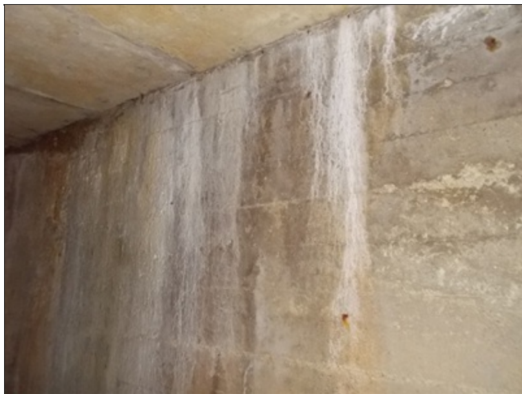
Zatékání na opěru
