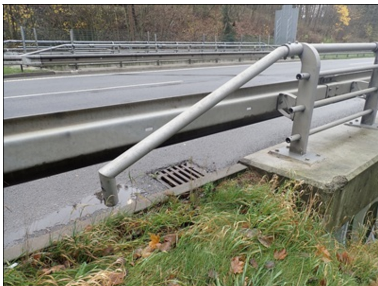
Ukončení horního madla svodidlového zábradlí před mostem vpravo
