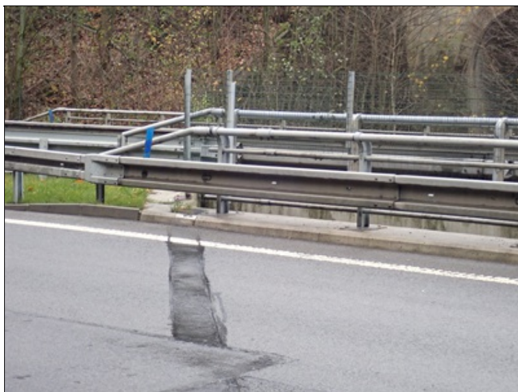
EMZ nad 1. opěrou a dilatace v římse vlevo
