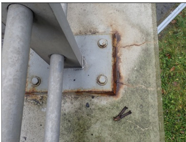
Kotevní desky svodidlového zábradlí
