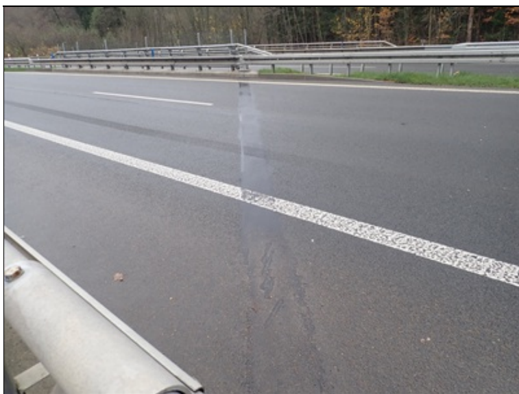
Dilatace ve vozovce nad 1. opěrou
