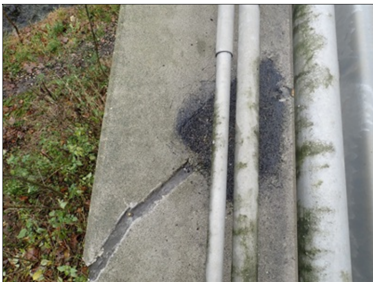
Dilatace v římse vlevo nad 1. opěrou po opravě
