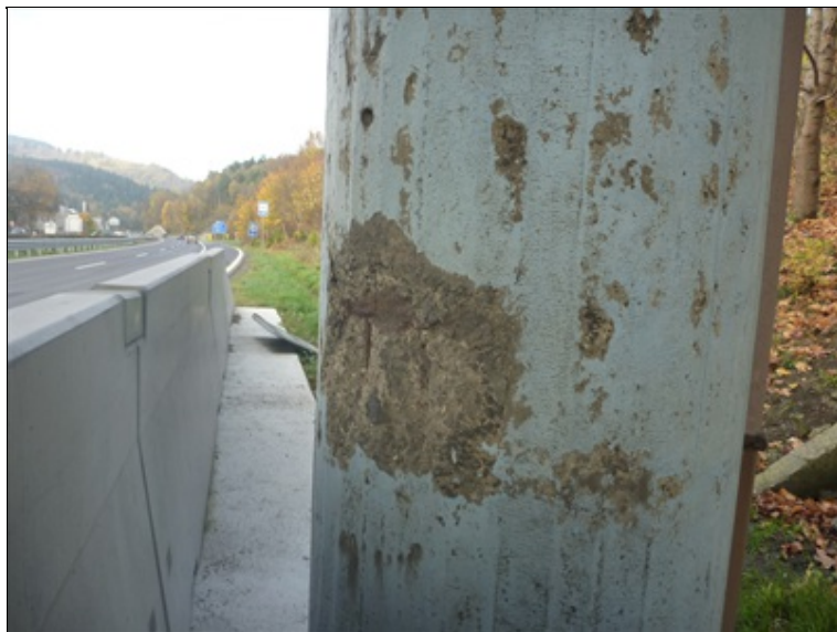
Poškozený sloup u levé střední podpěry
