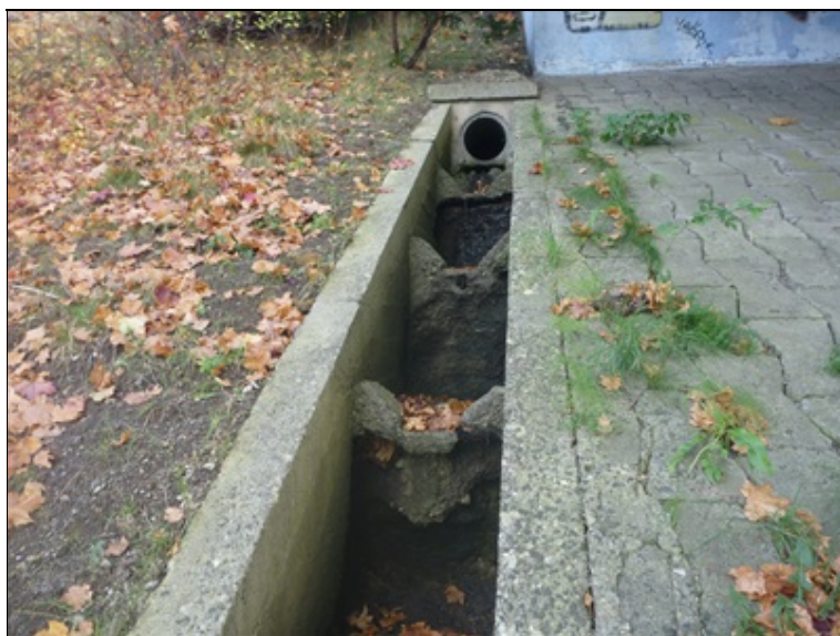
Odvodnění u levé opěry
