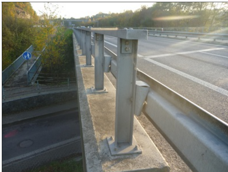
Poškozené svodidlové zábradlí vlevo
