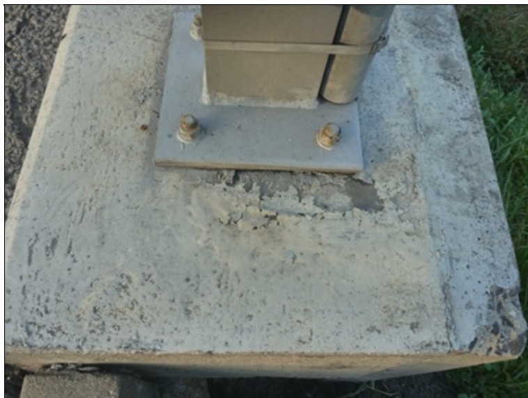
Poškozený nátěr římsy vlevo
