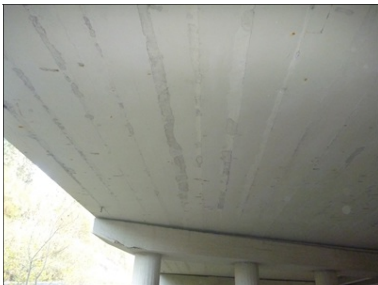
Podélné trhliny v podhledu NK
