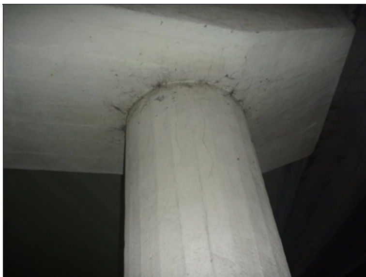
Trhliny v krajním sloupu vpravo u střední podpěry
