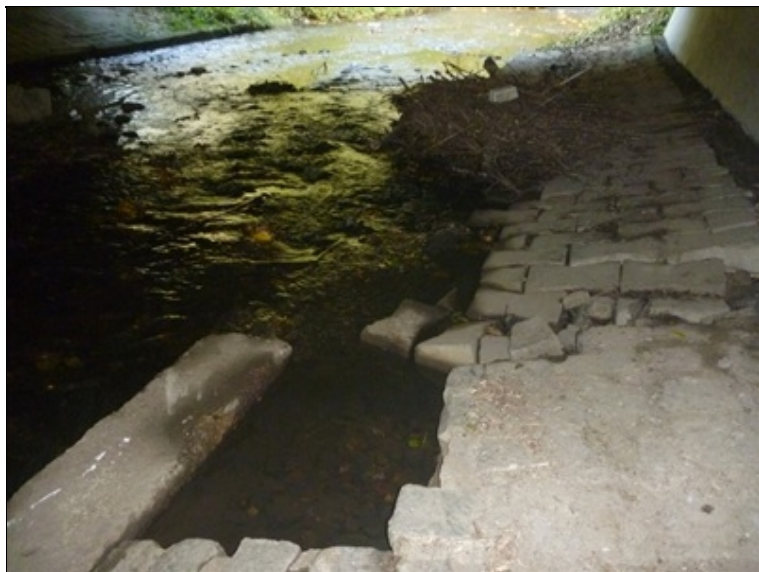
Poškozená zádlažba opevnění u 2.OP
