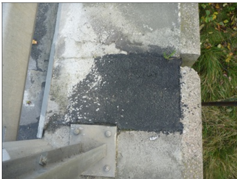
2.dilatace v římse vpravo
