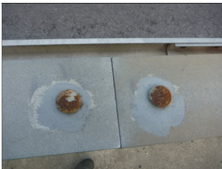
Koroze spojovacího materiálu zábradelního svodidla
