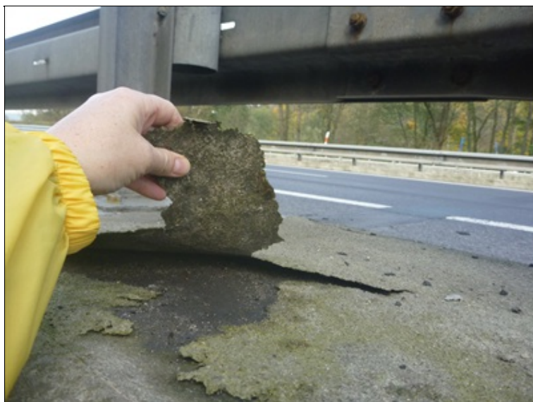
Poškozený ochranný nátěr říms
