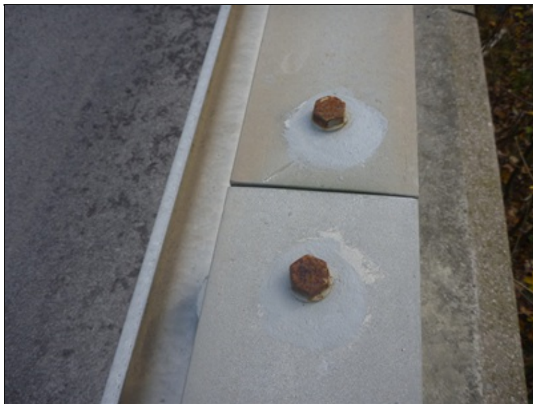
Korodující spojovací materiál svodidlového zábradlí
