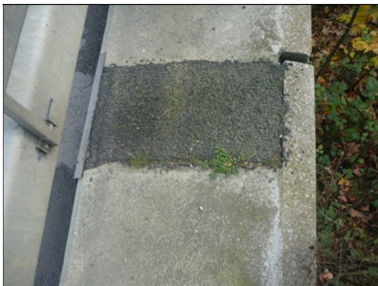
Dilatace v římse vpravo
