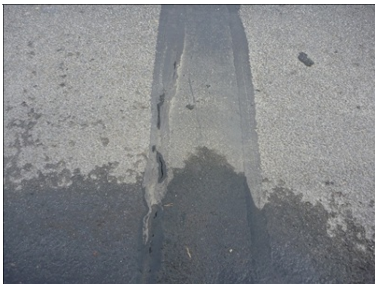
Otevřené trhliny ve 2.EMZ
