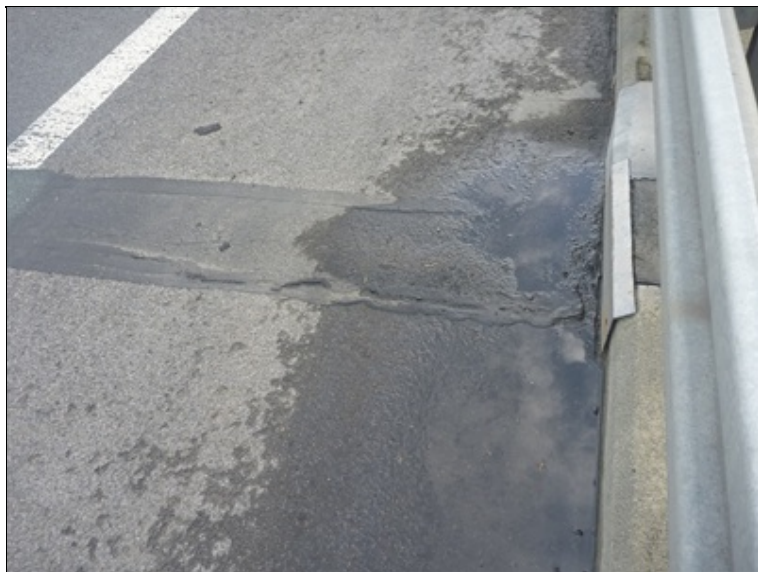
Poškozený 1.EMZ u římse
