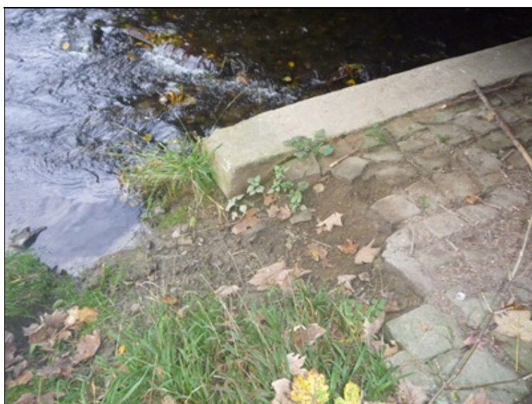
Poškozené opevnění 2.OP pod mostem
