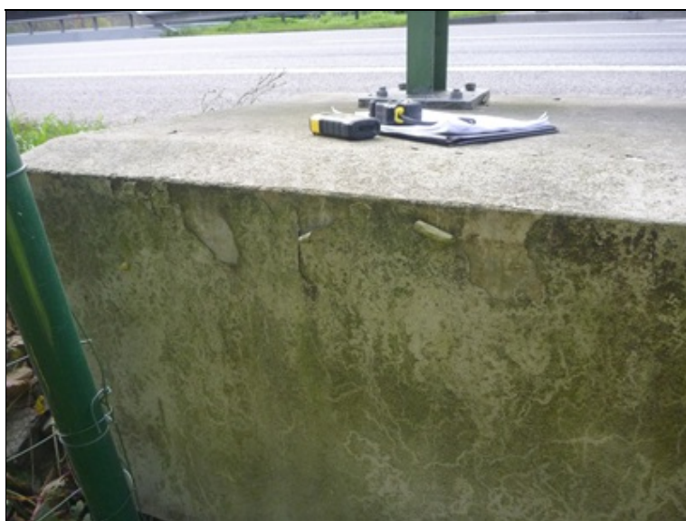
Poškozený ochranný nátěr římsy vlevo
