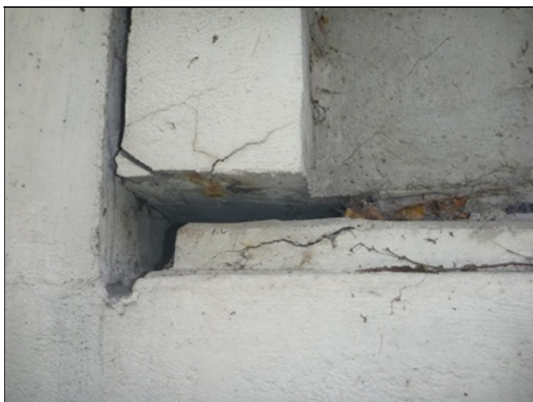
Detail koncového příčnicku a podložiskového bloku na 2.OP vlevo
