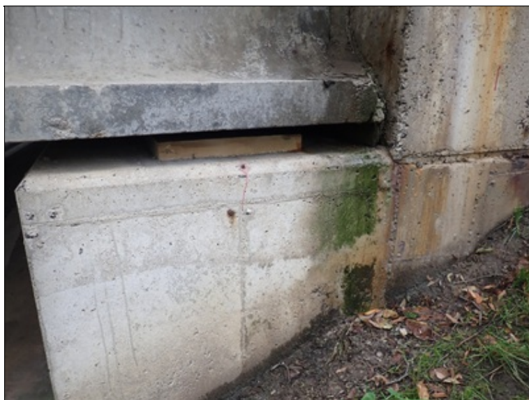
Závěrná zídka a úložný práh na 2.OP vpravo
