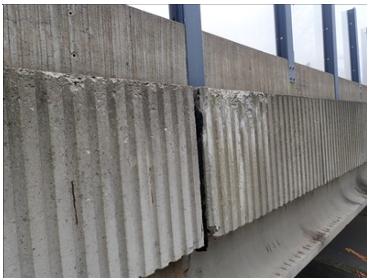
Degradace betonu římsového prefabrikátu vpravo
